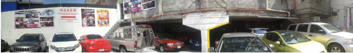
Fig. 2.3 Vista Lateral Derecha. Fuente: Foto Propia.
