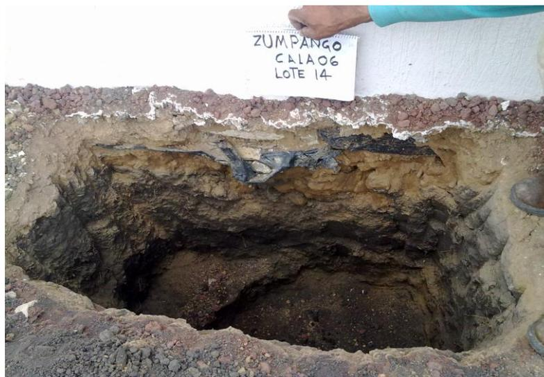
FIGURA 10.- PERFIL ESTRATIGRÁFICO DEL PCA-6
