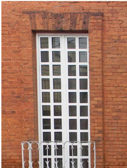
Figura 27. Arco adintelado fabricado en ladrillo, ubicado en la calle de Fragonard. Fotografía del autor.
