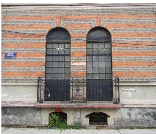
Figura 49. Muro con dos tipos de ladrillo, aparejo a sogas, ubicado en la calle Luis Caracci. Fotografía del autor.
