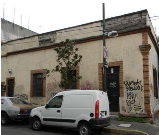
Figura 46. Muro aplanado con enmarcamientos de ladrillo a cara vista, ubicado en la calle Giotto. Fotografía del autor.
