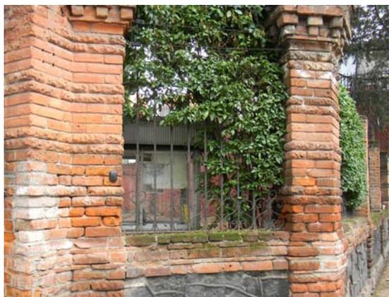
Figura 36. Detalle de pilastras que desplantan del nivel de piso terminado, ubicadas en la calle de Donatello. *Fotografía del autor.*
