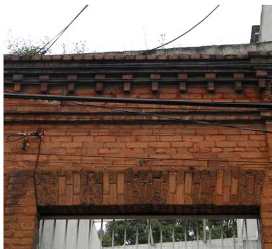
Figura 31. Detalle de cornisa de ladrillo y amarre de ladrillo en muro, ubicada en la calle de Donatello. Fotografía del autor.
