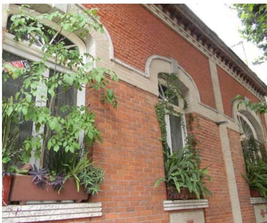
Figura 44. Muro con aparejo a sogas desplantando de un rodapié de piedra, ubicado en la calle Goya. Fotografía del autor.
