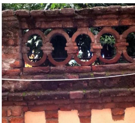
Figura 39. Detalle de pretil sobre cornisa, ésta presenta elementos curvos fabricados también con barro, elementos fabricados en las ladrilleras de San Juan, ubicada en la calle de Goya. *Fotografía del autor.*
