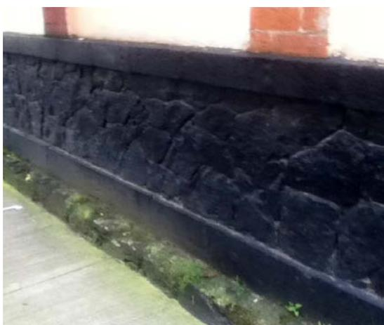
Figura 57. Rodapié en aparejo poligonal. Fotografía tomada del autor, 2014.
