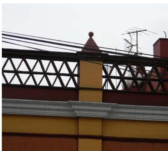
Figura 40. Detalle de pretil fabricada con soleras de barro, interactuando con la cornisa y pilastra que remata con un pináculo, ubicadas en la calle Leonardo Da Vinci. *Fotografía del autor.*
