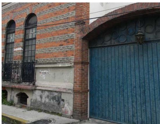
Figura 34. Detalle de pilastra que desplantan del nivel de piso terminado, ubicadas en la calle de Luis Caracci. *Fotografía del autor.*
