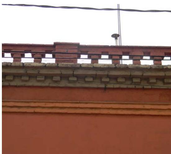
Figura 38. Detalle de pretil interactuando con pilastra y cornisa, en la parte inferior de la cornisa se aprecia el amarre del muro característico en Mixcoac, ubicadas en la calle Augusto Rodin. *Fotografía del autor.*
