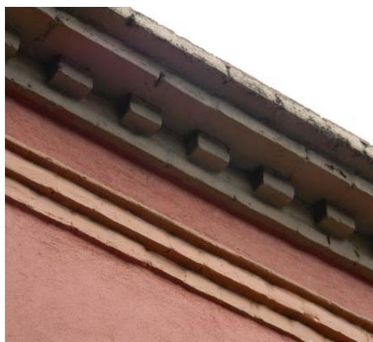
Figura 33. Detalle de cornisa de ladrillo y amarre de ladrillo en muro, ubicada en la calle de La Castañeda. Fotografía del autor.
