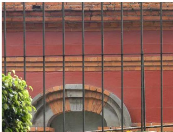
Figura 28. Arco deprimido, fabricado en ladrillo con dovela y salmer de cantera, ubicado en la calle de Actipan. Fotografía del autor.
