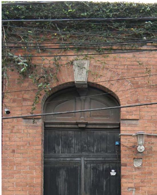
Figura 26. Arco carpanel de tres centros, fabricado en ladrillo con dovela de cantera, ubicado en la calle de Luis Caracci. Fotografía del autor.
