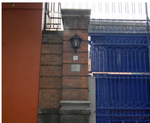
Figura 35. Detalle de pilastras que desplantan de un rodapié de piedra, ubicadas en la calle de la Campana. *Fotografía del autor.*
