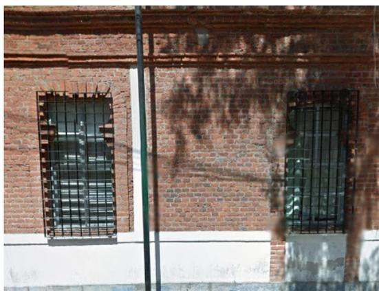
Figura 42. Muro con aparejo a tizones desplantando de un rodapié de piedra, ubicado en la calle Donatello. *Fotografía del autor.*
