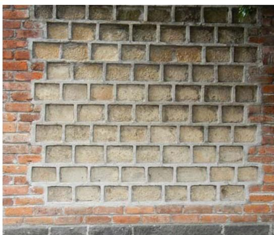
Figura 47. Muro compuesto, de ladrillo y tepetate, ubicado en la calle Los Echave. Fotografía del autor.
