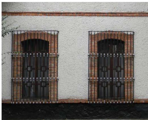
Figura 29. Arcos escarzos fabricados en ladrillo, ubicados en la calle de Poussin. Fotografía del autor.
