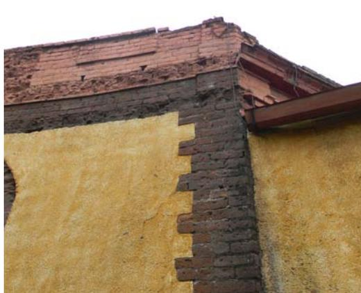
Figura 37. Detalle de pilastras con adaraja para amarre a muro, ubicadas en la calle Leonardo Da Vinci. *Fotografía del autor.*
