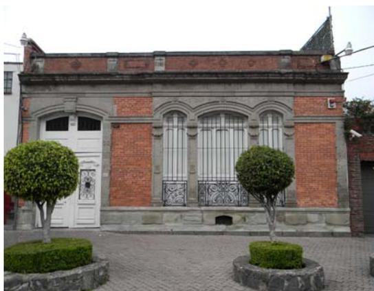
Figura 43. Muro con aparejo a sogas desplantando de un rodapié de piedra, ubicado en la calle Augusto Rodin. *Fotografía del autor.*
