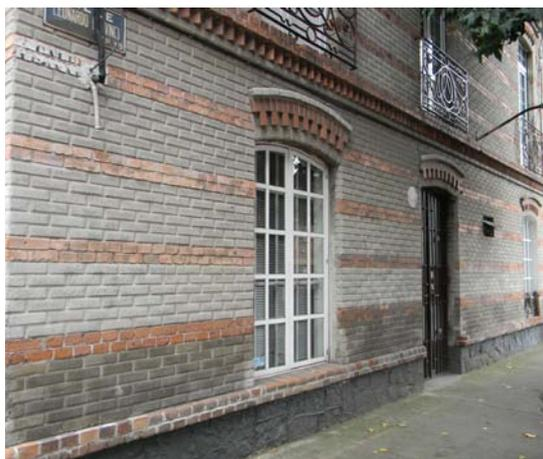
Figura 45. Muro con dos tipos distintos de ladrillo; aparejo de ladrillo gris a sogas y ladrillo rojo a tizonas, desplantando de un rodapié de piedra, ubicado en la calle Leonardo Da Vinci. Fotografía del autor.
