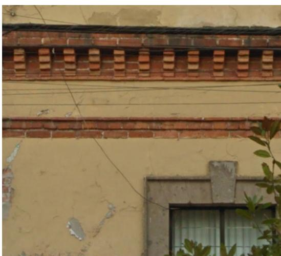
Figura 32. Detalle de cornisa de ladrillo y amarre de ladrillo en muro, ubicada en la calle de Leonardo Da Vinci. Fotografía del autor.
