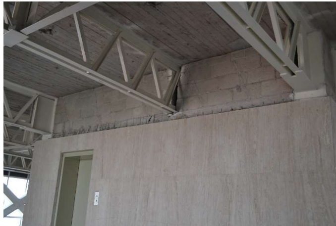
Fig. 3.3 Mampostería de cubo de elevadores y escaleras
