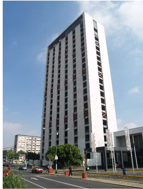
Fig. 2.16 Foto del CCUT durante los trabajos de restructuración
