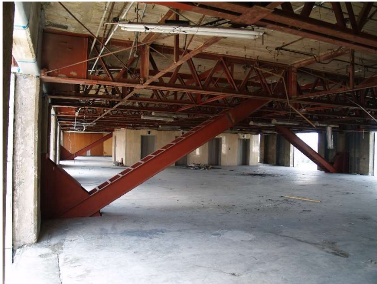
Fig. 2.14 Contravientos de rehabilitación en superestructura
