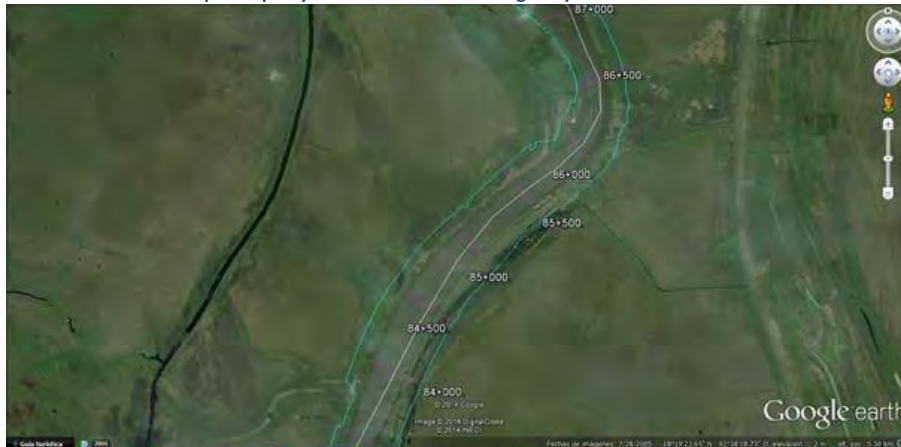
Figura 58 Delimitación del cauce principal y ubicación de líneas guía para toma de secciones transversales.
