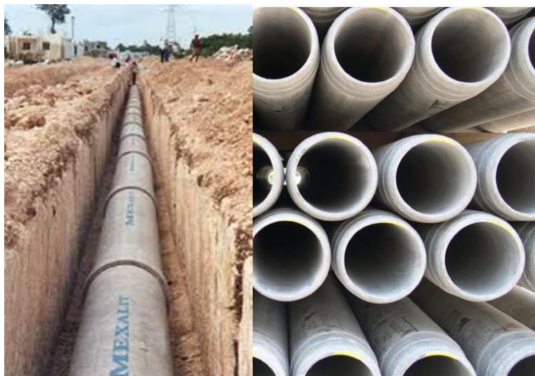
Figura 1. 5. Tendido de tubería de fibrocemento con sistemas de conexión espiga - campana
