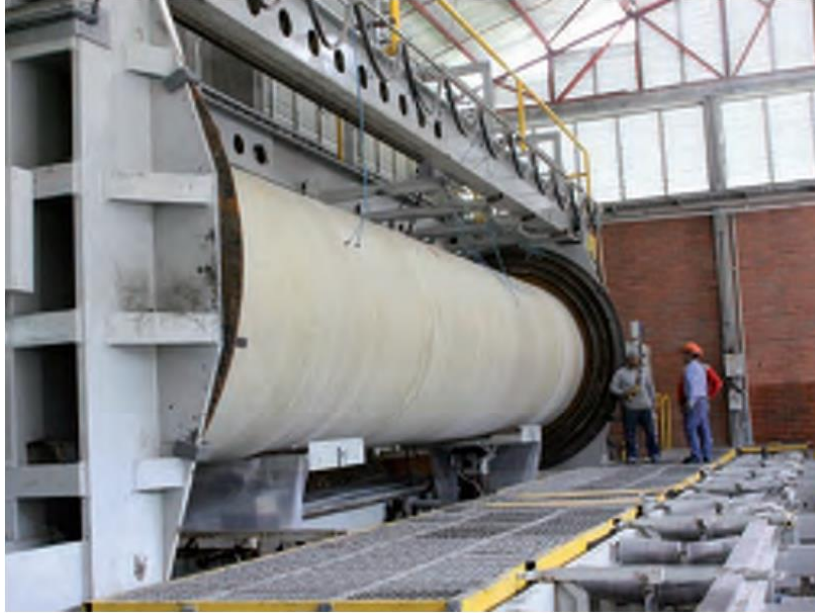
Figura 1. 12. Fabricación de tuberías de PRFV
