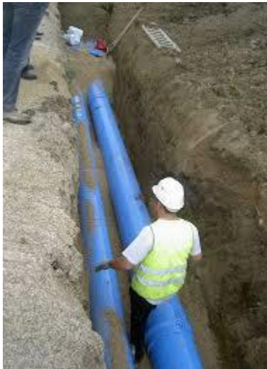
Figura 1. 9. Tendido de tubería de PVC
