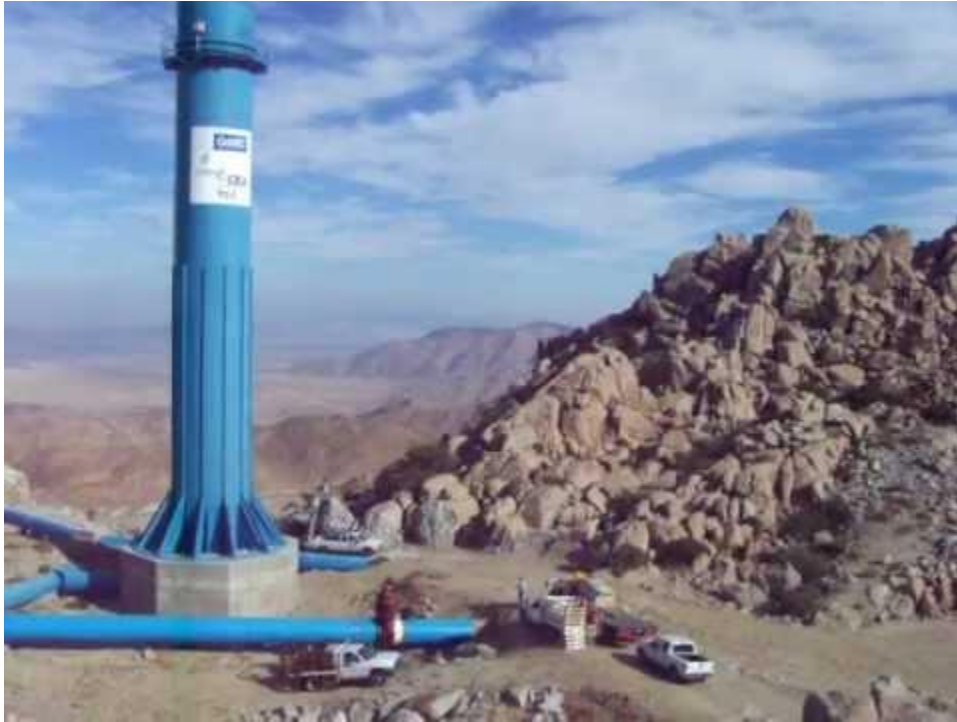
Figura 1. 43. Torre de oscilación, Acueducto Río Colorado – Tijuana
