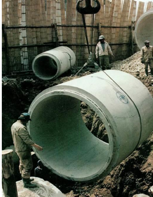
Figura 1. 6. Izaje y colocación de una tubería de concreto
