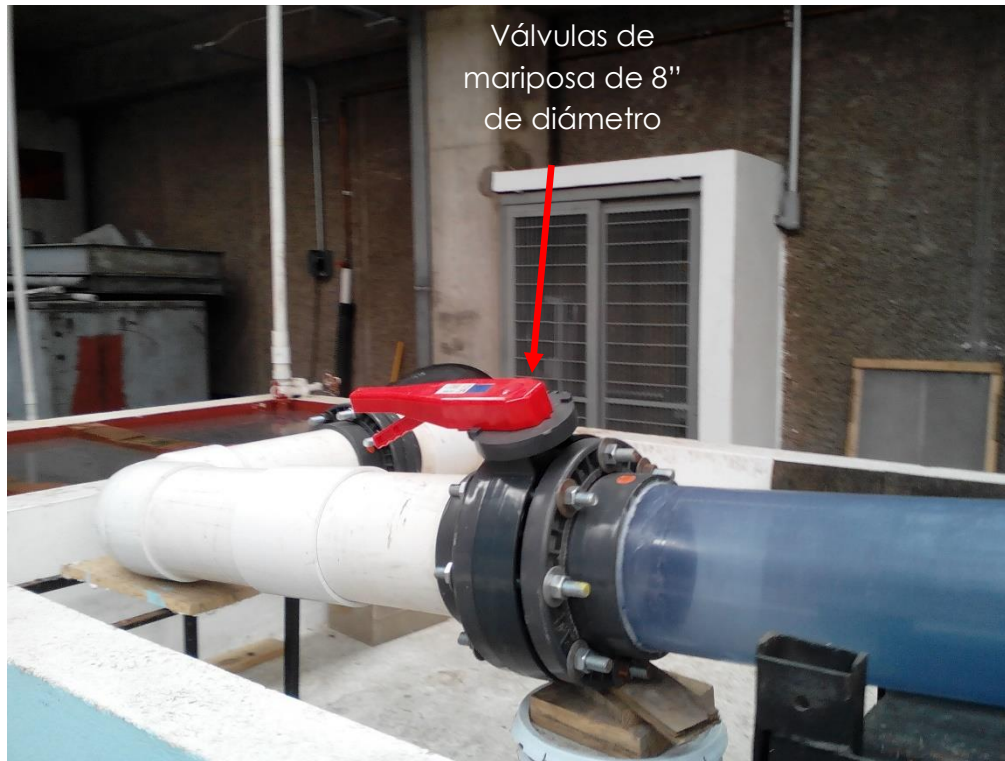
Figura 4. 10. Sección de descarga del sistema
