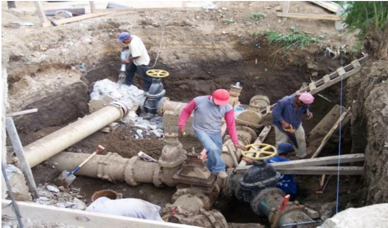
Figura 1. 29. Cruce de tubería de agua potable
