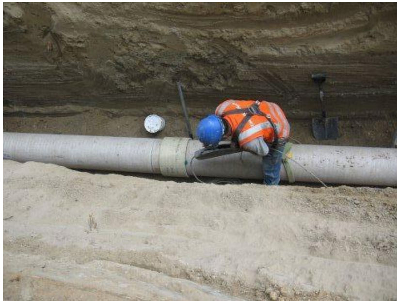
Figura 1. 13. Tendido de tuberías de PRFV
