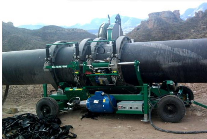
Figura 1. 11. Unión por Termo-fusión en tuberías de PEAD
