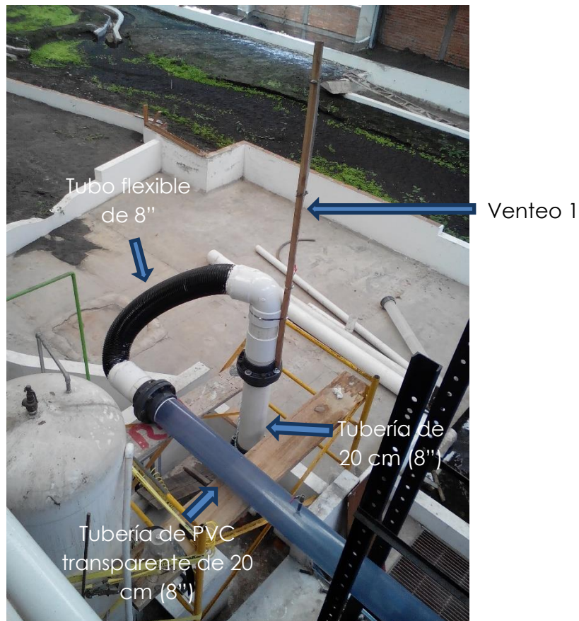
Figura 4. 6. Tramo de ampliación en línea de conducción
