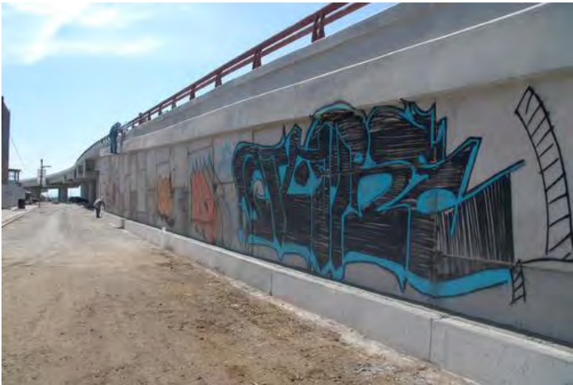
Figura 31. LOS PUENTES DE LA GENTE. Durante La administración del gobernador Humberto Moreira denominado “El gobierno de la Gente” por su eslogan, se construyeron, en conjunto con la presidencia municipal, ambos del mismo partido político (PRI), una gran cantidad de puentes distribuidos por toda la Ciudad. Así se justificó parte de los gastos del Estado que después fue conocida como La “Gran Estafa” o el pequeño Fobaproa. Coahuila adquirió una deuda de más de treinta y tres mil cien millones de pesos, la más grande de la Historia en el Estado y que deja un gran endeudamiento para las futuras generaciones. En la imagen se aprecia el puente, aún sin inaugurar y ya gaffiteado. Fuente: Periódico “el Siglo de Torreón.
