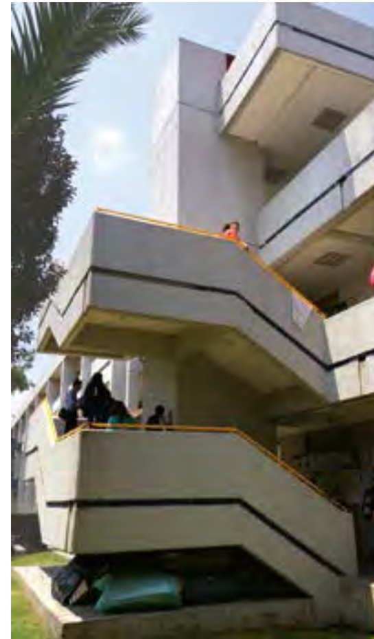
Las escaleras de la FES tiene barandal e incluso más adelante en la nave se construyeron nuevas escaleras de emergencia.
