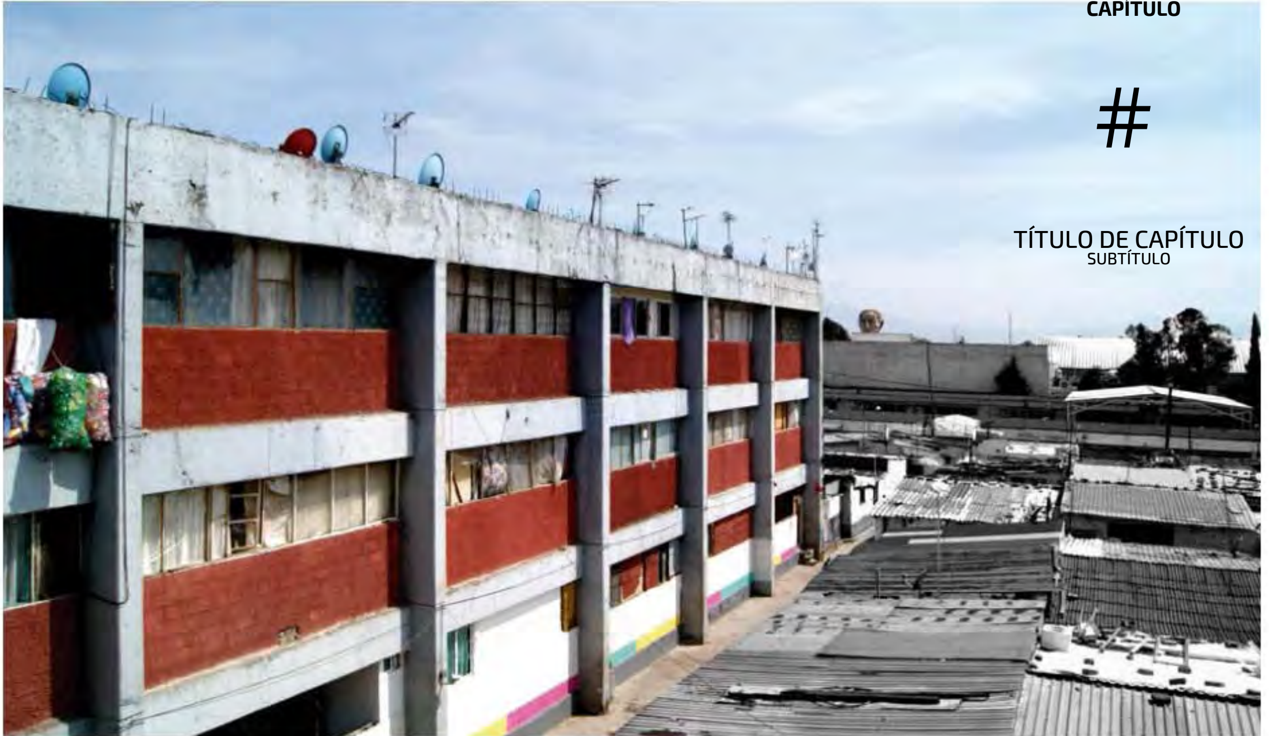
Vista sur, al interior del predio. Se observan los módulos ubicados al centro fuera de los edificios.
