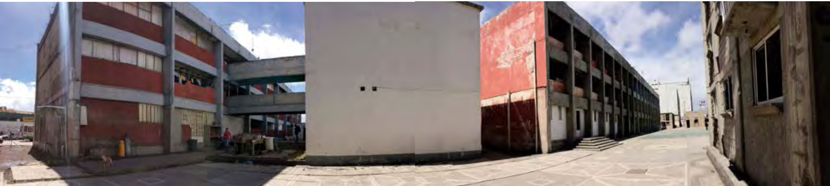
Fotografía panorámica de Conjunto. A la izquierda vemos el edificio oriente (colinda con la avenida Guelatao) y avanzando hacia la derecha se observa el área de lavado el núcleo de circulación y el edificio principal, la explanada y por último la construcción más reciente; un edificio de departamentos de 6 niveles sin habitar aún.
