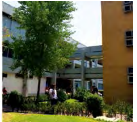
En la FES el área que en el predio es de lavado aquí es jardinada, se encuentra entre un edificio y el núcleo de sanitarios.
