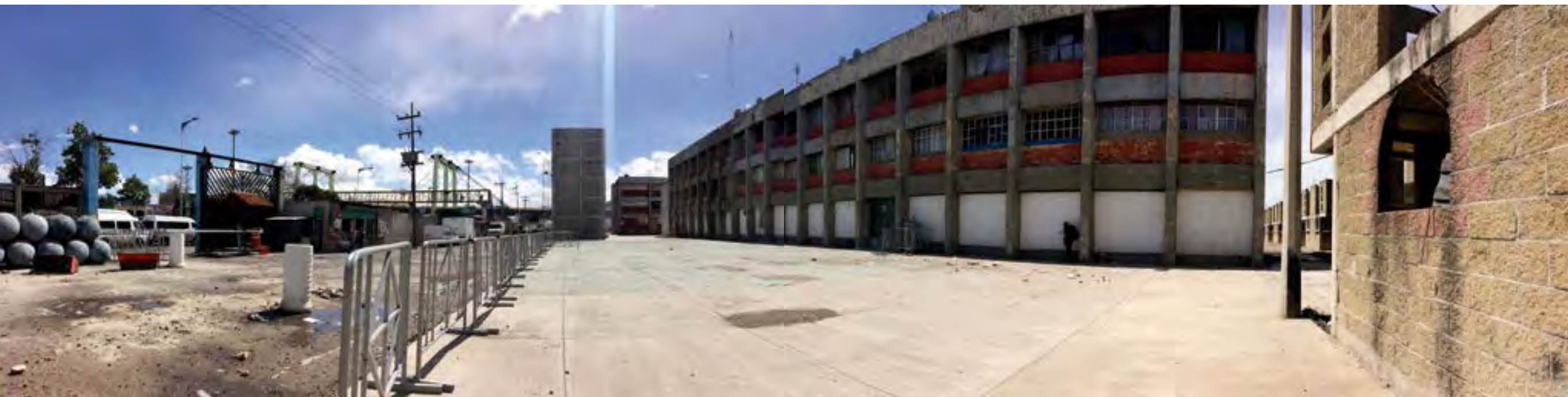
Fotografía panorámica edificio "A". A la izquierda se encuentra el portón vehicular, la explanada principal, el edificio norte que colinda con la calzada Zaragoza y otra área de módulos de vivienda. En esta toma podemos ver otra vista del edificio de 6 niveles y la fachada de la estructura principal.
