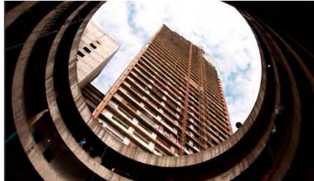
Vista desde la rampa de estacionamiento hacia la torre principal de la Torre de David. Fotografía de Danielle Bello.
