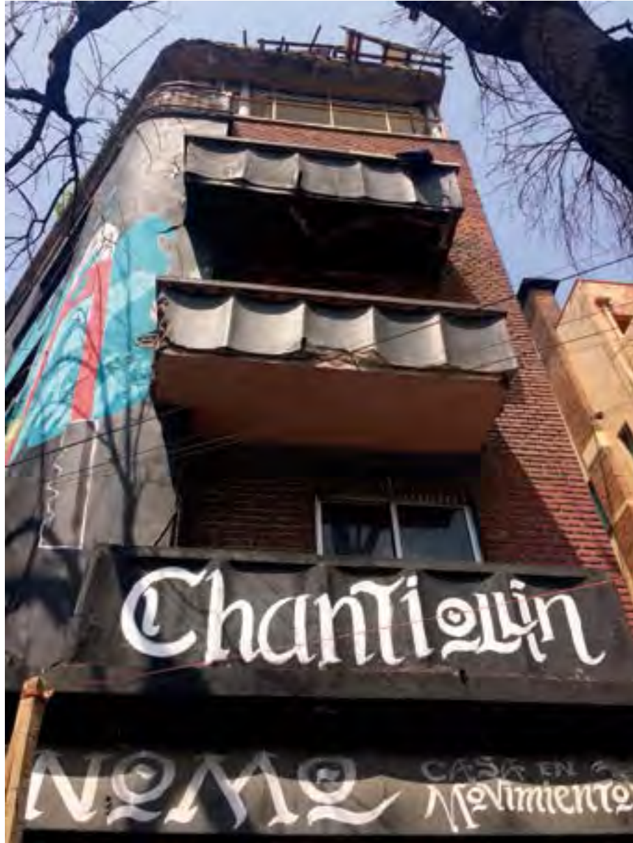
Fachada de la Calle Elba, se observan los balcones de las habitaciones.
