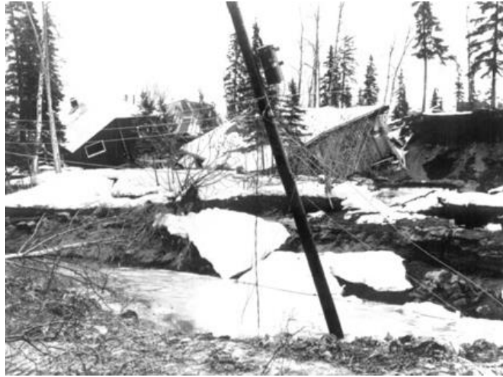
Fig 1.4 Derrumbe en el área de Turnagain Heights, Anchorage (USGS, 2012)
