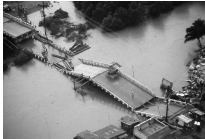
Fig 2.8 Puente Magsaysay colapsado por desplazamiento lateral del suelo (Bird y Bommer, 2004)
