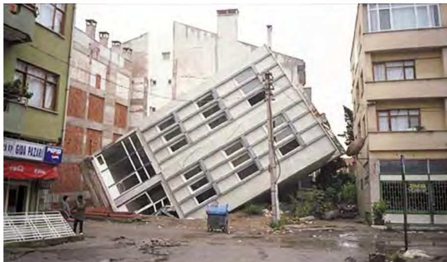
Fig 2.19 Edificio volcado en Adapazari (USGS, 2000)
