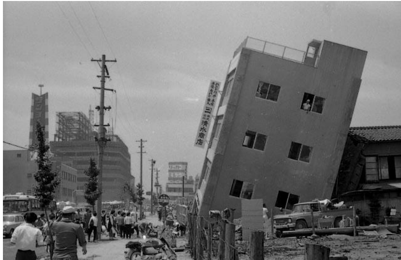
Fig 2.4 Edificio con asentamiento diferencial e inclinación (Past Niigata, 2015)
