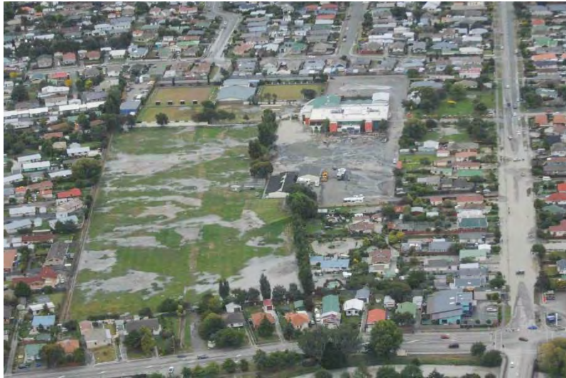
Fig 2.45 Licuación en zona residencial de Christchurch (NCEI, 2015)
