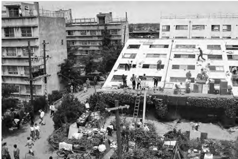
Fig 2.3 Edificio sin daño en superestructura, volcado a causa de la licuación (Syracuse Media Group, 2015)
