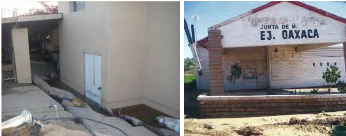
(a) (b) Fig 2.39 a) Vivienda con asentamiento uniforme de cerca de 1 m (GEER Association, 2010b) b) inmueble en el valle de Mexicali asentado por licuación del suelo (Jaimes et al. , 2010)
