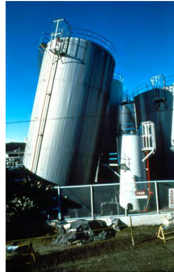
Fig 2.14 Tanque inclinado en zona costera de Kobe (National Platform for Natural Hazards, 2015)
