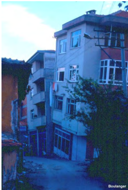
Fig 2.16 Construcciones de cuatro niveles inclinadas a causa de la licuación del suelo (University of California, Davis campus, 2015)
