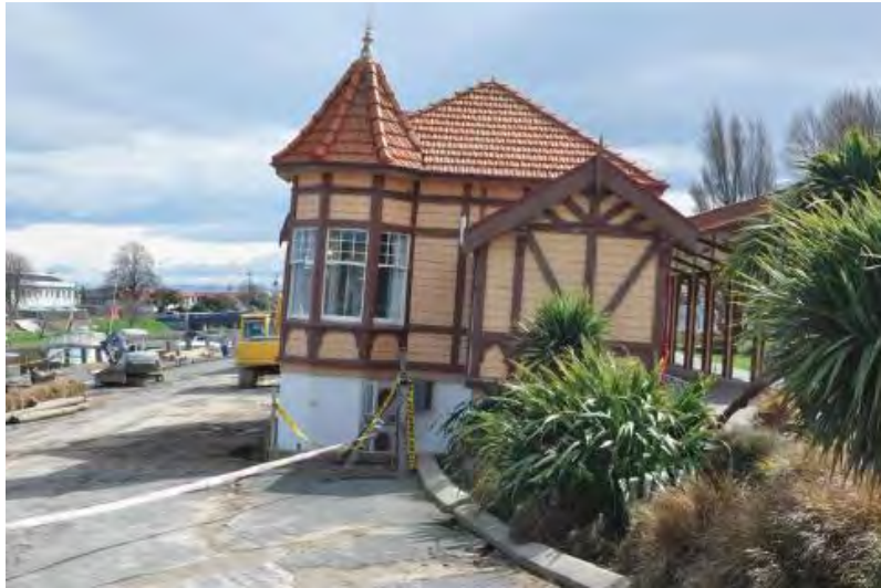
Fig 2.42 Vista noroeste del Centro de Información de Kaiapoi (GEER Association, 2010c)
