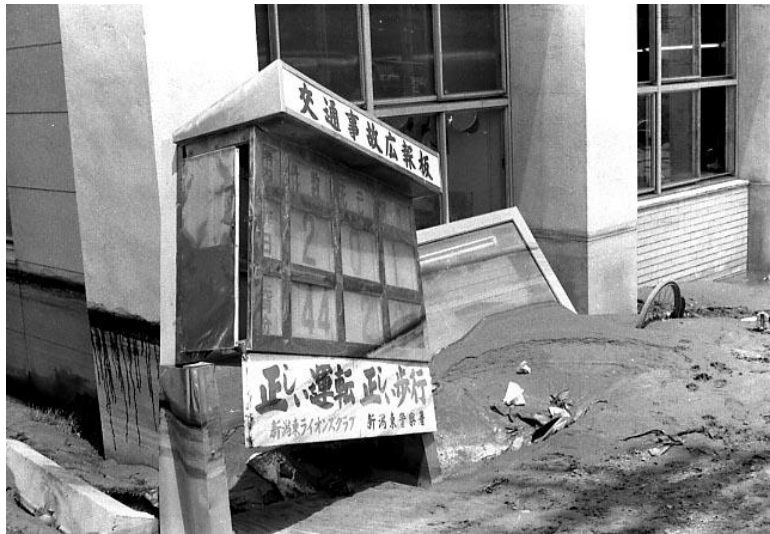
Fig 2.5 Evidencia de licuación afuera de la estación de policía de Higashi (Past Niigata, 2015)
