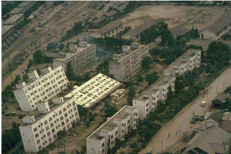
Fig 1.5 Asentamiento e inclinación de edificios en Kawagishi-cho, Japón (Civil and Environmental Engineering, University of Washington, 2000)
