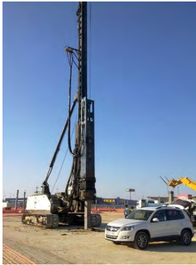
Fig 3.4 Hincado de pilotes prefabricados (CFT & Asociados S.L., 2013)
