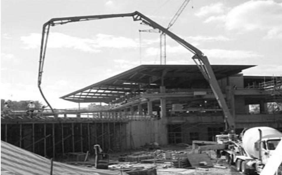
Figura 63. Equipo de bombeo móvil montado en camión, autobomba.
