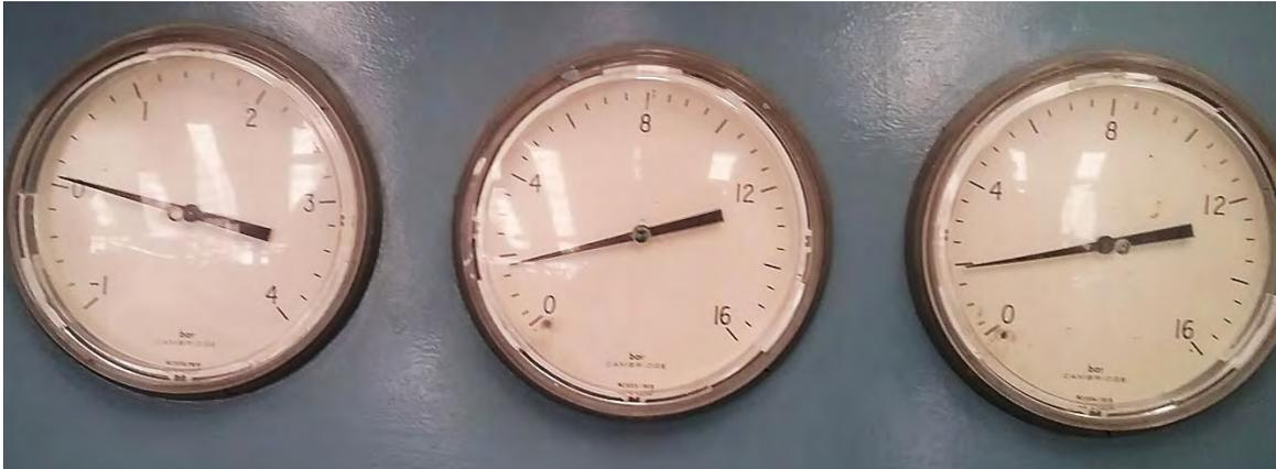
**Figura 5.1.3** Presión Salida de turbina, Presión entrada de turbina Presión vapor de línea
