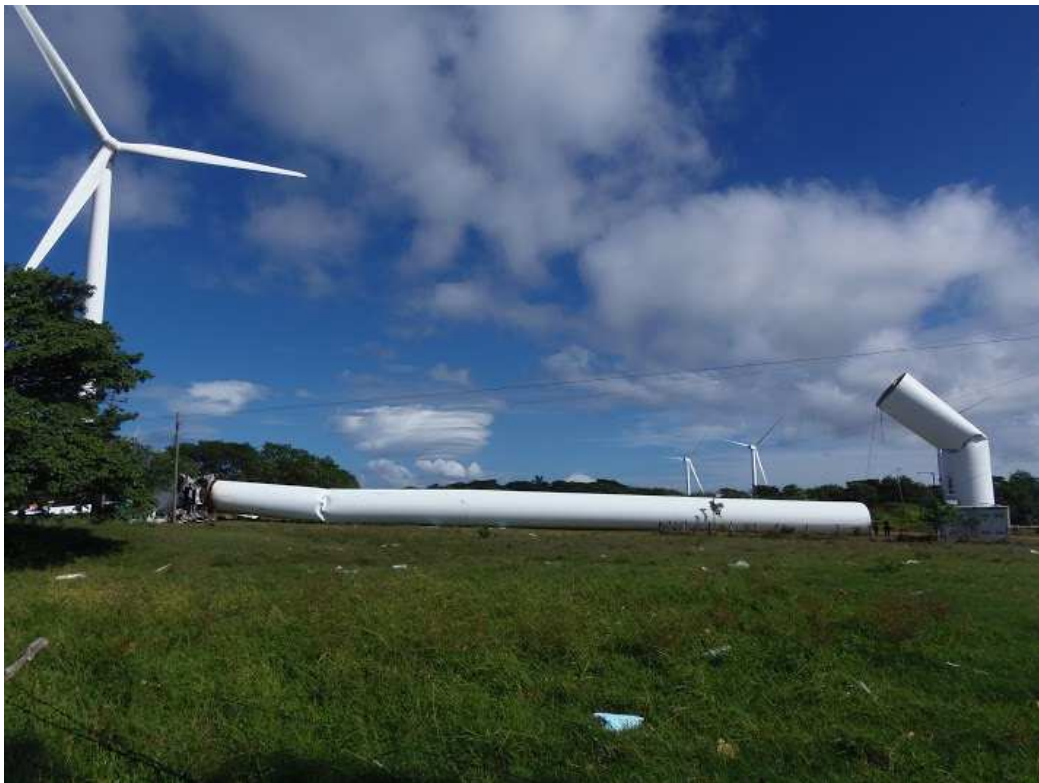
Figura 2.7 Colapso de torre aerogenerador en un parque eólico, ciudad de Rivas, Nicaragua (2004).
