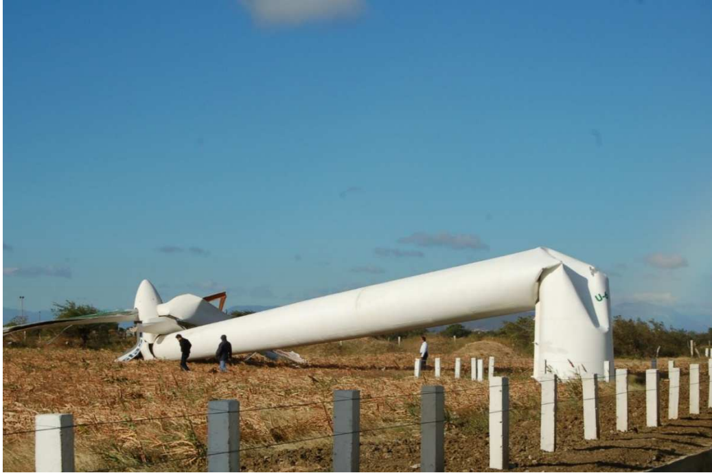
Figura 2.6 Colapso de torre de aerogenerador en un parque eólico, Oaxaca, México (2006).
