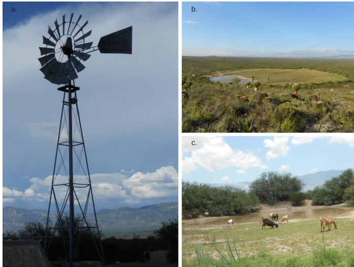
Figura 9. Infraestructura hidráulica en Las Margaritas. a. Pozo de agua con bomba eólica; b. y c. tanques de almacenamiento superficial de agua. Fotografía Solano, 2014.
