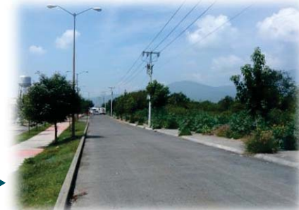
Avenida de la Cantera
