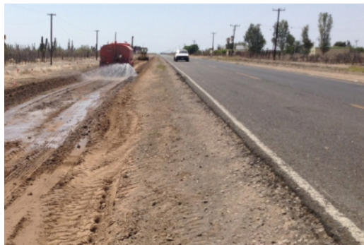
Imagen 1.0.- Carretera tramo Cd. Constitución - Cd. Insurgentes cuatro carriles.
