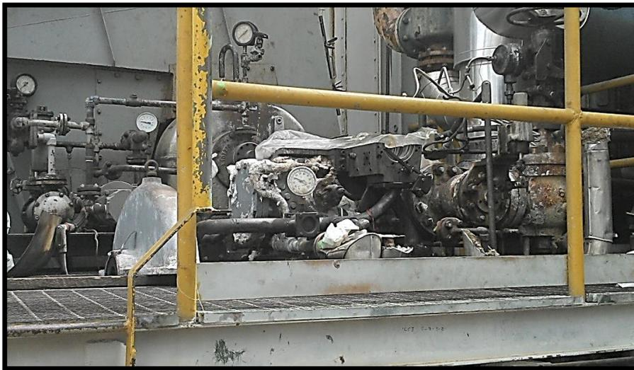
**Imagen 29. Carcasa en el piso y la turbina tapada y sin rotor y completamente inoperable.**
