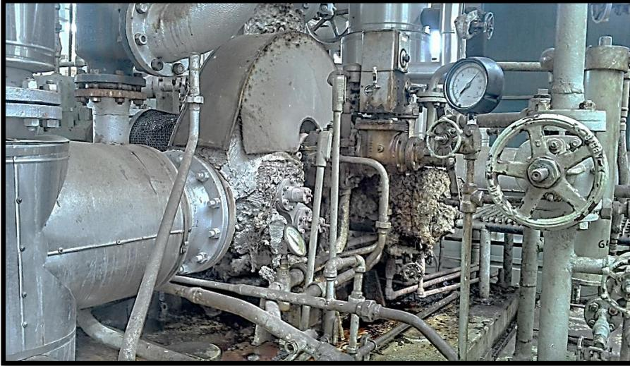
**Imagen 31. Turbina parada debido a la falta de mantenimiento.**
