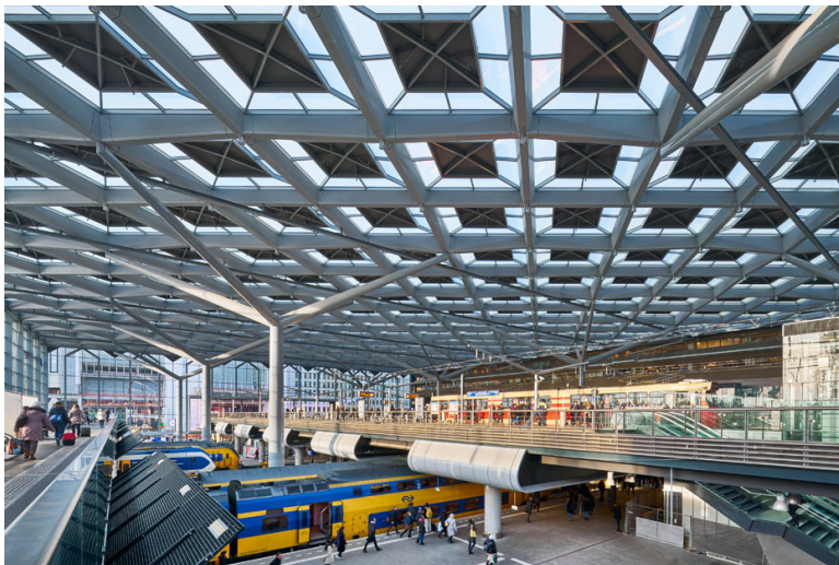
Figura 48. Linders, J. Vista interior de la estación de trenes.
