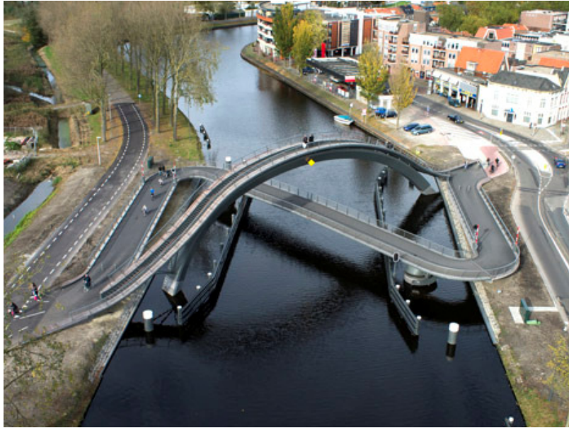
Figura 38. Musch, J., Vista aérea de puente en donde se observa la configuración de las tres trayectorias.
