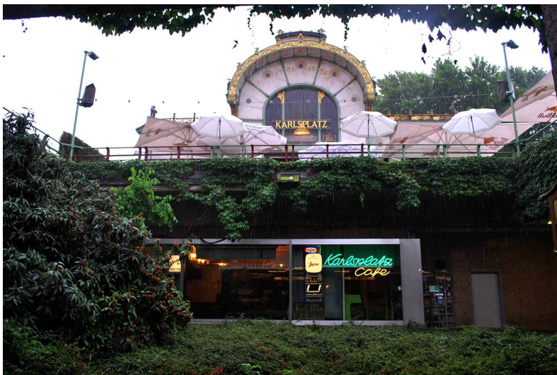
Figura 10. Fernández, A. Estación de metro Karlplatz en Viena, Austria.
