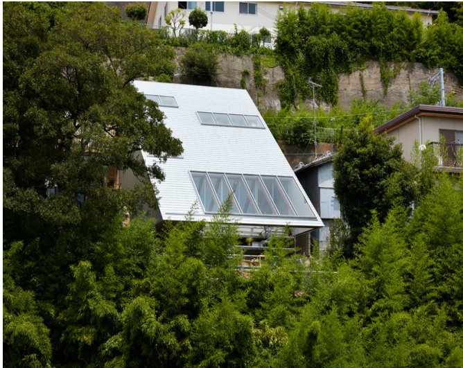
Figura 28. Yano, T. Following the natural gradient of the hill, a wedged shaped property was realized. Vista exterior de la vivienda en la que se aprecia la integración de la volumetría con la topografía del terreno. Lo que permite la generación de espacios equiparables a la conexión de uso.
