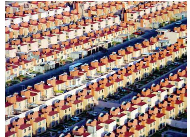
Imagen 12. Casas GEO en Tultitlán, Estado de México
