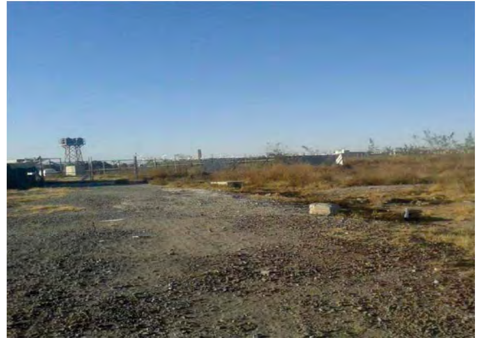
Imagen 37. Fotografía de la subestación en el terreno
