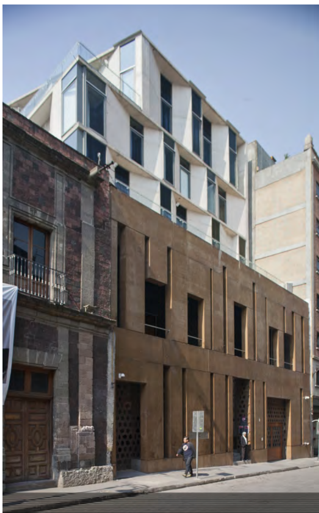
figura 1. fotografía fachada calle República de Guatemala
