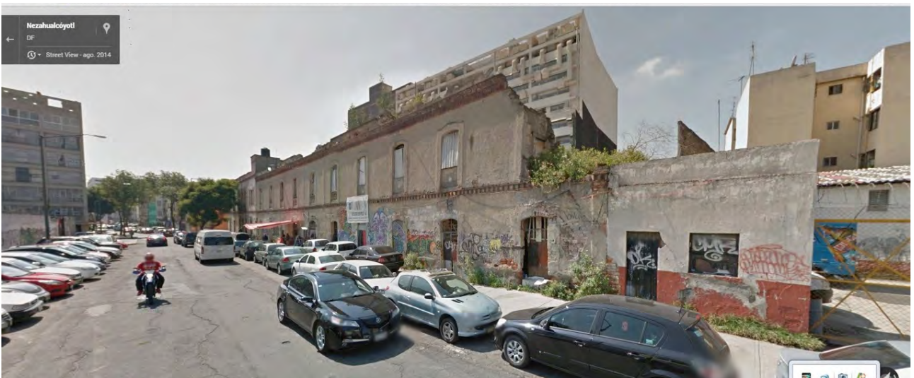
Figura 7 Imagen Fachada calle Nezahualcóyotl Fuente: Google Maps.
