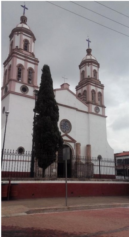
Iglesia del Socorro principal de Ario de Rosales ubicada en el centro histórico del municipio.
