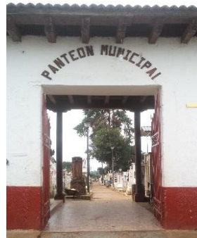
Entrada principal del panteón (se encuentra a lado izquierdo al oriente del terreno)
