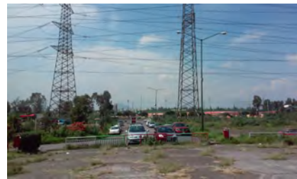
114. Eje vial al interior del predio
