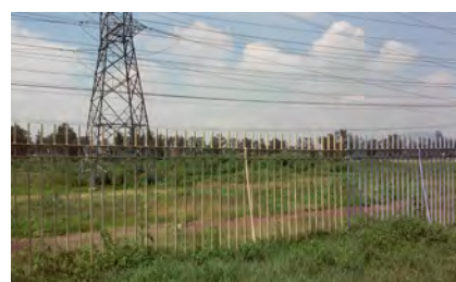
118. Valla perimetral de metal
