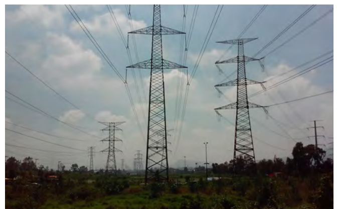
112. Torres eléctricas en parte sur, predio norte
