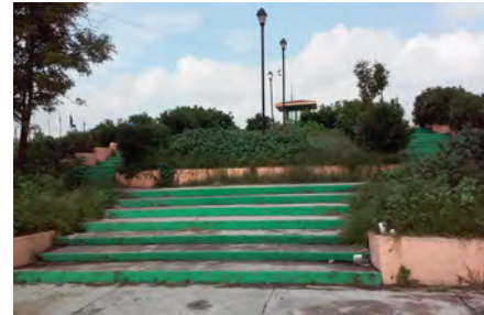
27. Acceso oriente predio Sur.
