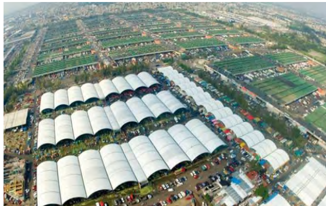
13. Vista aérea de la Central de Abasto
