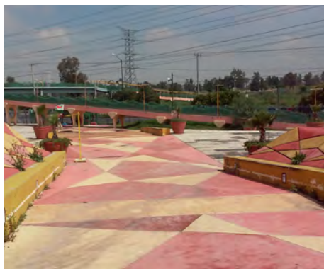
38. Acceso principal al predio sur
