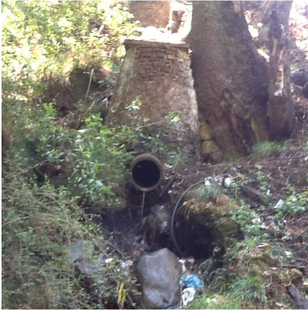
Figura 46. Fotografía que colecta y vierte el drenaje de diversas viviendas al río dentro del caso 2. Fotografía del autor.
