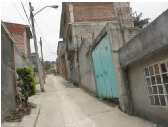
Figura 27. Viviendas ubicadas cerca de la barranca del río borracho. (Ver referencia figura 23▶). Fotografía del autor.
