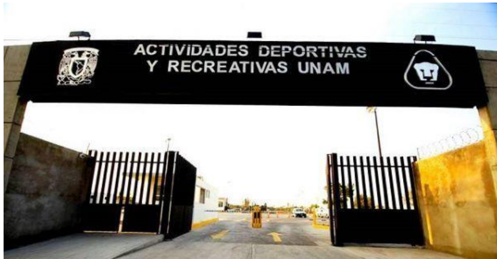
Imagen 2. Polideportivo Universitario, en su primer etapa
