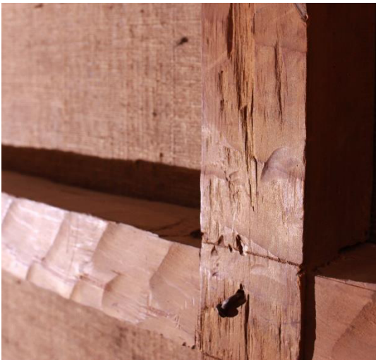
Fig. 139 La cruceta está armada con un ensamble a media madera y se reforzó con un clavo. Fotografía Elizabeth Vite.
