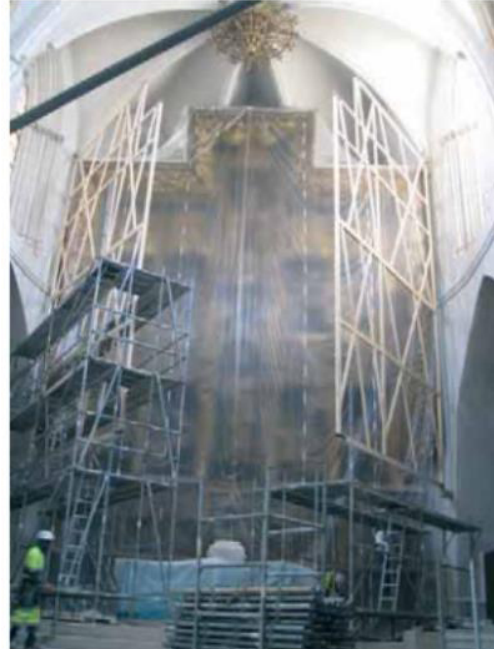
Fig. 23 Fotografías del proceso de reconstrucción de las puertas del altar mayor de San Pablo, Zaragoza. Se observa que un marco perimetral se refuerza con varios travesaños horizontales y verticales, además de otros miembros colocados diagonalmente en intervalos. El diseño de patrones con formas triangulares genera una estructura resistente en la que las fuerzas ocasionadas por la tensión y peso de las telas se equilibran. Fotografía tomada de Rocío Bruquetas, “Recuperación de las puertas del retablo mayor de San Pablo”, en Aragón turístico y monumental , Zaragoza, SIPA, 2015, p. 7.
