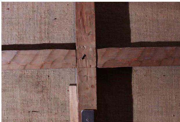
Fig. 145 Huellas de sierra en la cara del cabezal superior. Fotografía Carlos García Silva.
