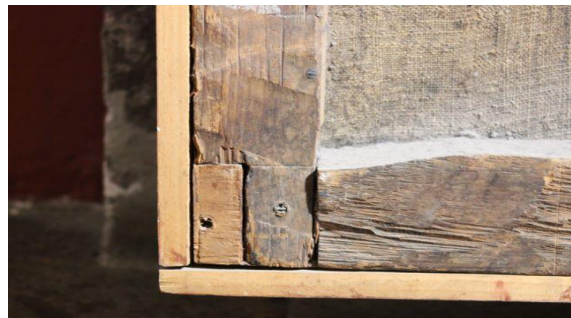
Fig. 138 Ensamble en “T” que une al larguero izquierdo con el cabezal inferior, se aprecia una reposición moderna. Fotografía Elizabeth Vite.
