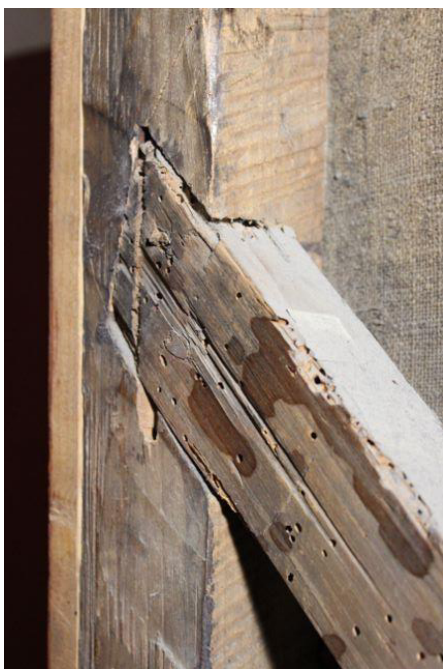
Fig. 141 Ensamble a media madera entre la escuadra inferior izquierda y el larguero izquierdo. Fotografía Elizabeth Vite.
