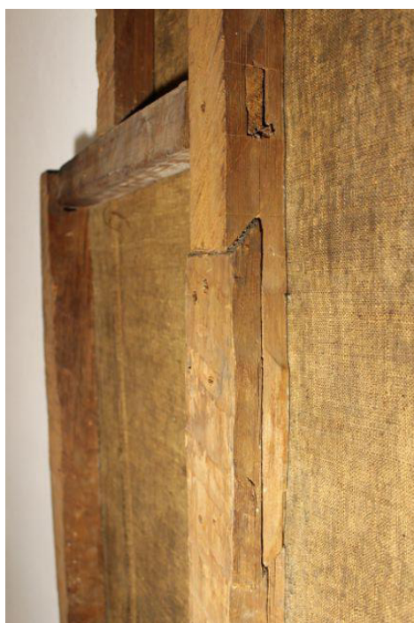
Fig. 148 Detalle del ensamble entre el travesaño inferior y el larguero izquierdo. Se observa además el ensamble de media madera en diagonal usado para unir las dos secciones que conforman el larguero. Fotografía de Carlos García Silva.
