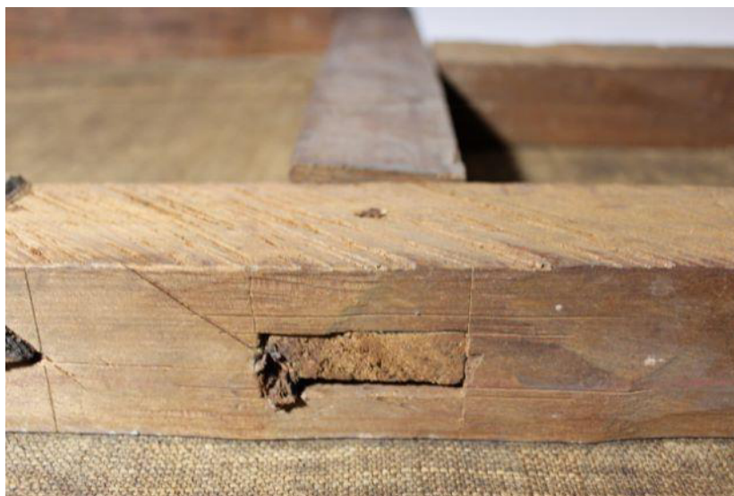
Fig. 156 La imagen muestra las marcas, hechas con punta metálica, para señalar las zonas de corte y ensamble del larguero izquierdo y el travesaño inferior. También se observan marcas de sierra en la cara del larguero y de cepillo en su canto. Fotografía Elizabeth Vite
