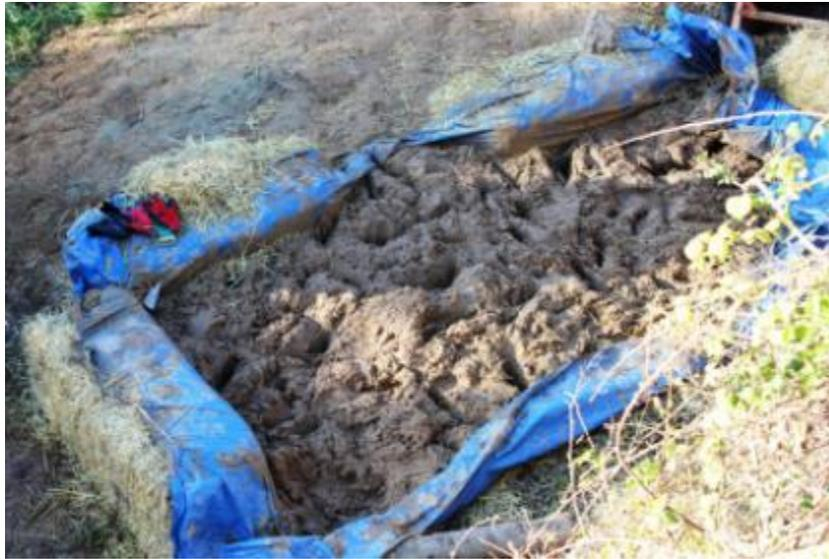
Ilustración 4. Proceso de dormido, fermentado o podrido del barro. (Imagen Extraída de: <https://biosfera2030.wordpress.com/2015/04/11/m2-taller-de-adobe/>)
