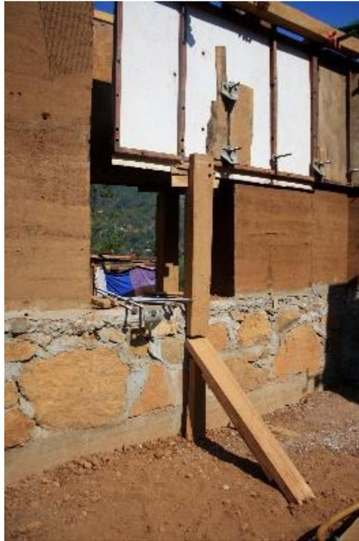
*Ilustración 10. Ajuste de cimbra de madera en muro de tapia sobre cadena de concreto y rodapie de mampostería. Imagen extraída de: Registro, Taller de construcción de vivienda con Tapial. C.A.M.P.O A.C.*
