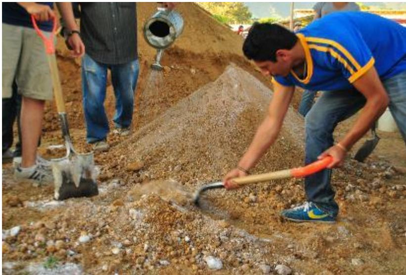
*Ilustración 7. Proceso de mezcla y riego de tierra para tapia. Imagen extraída de: Registro, Taller de construcción de vivienda con Tapial. C.A.M.P.O.A.C.*
