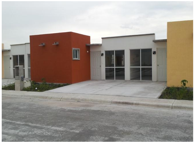
Fachada principal, prototipo Capri, Villas de Zumpango
