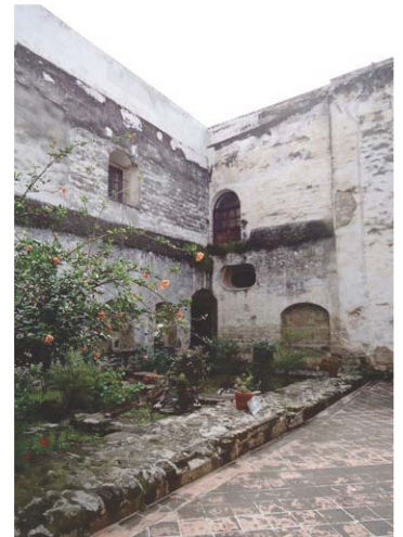
Vista del Patio de Servicio en su estado actual. Del lado izquierdo se pueden observar los vestigios de una antigua crujía. La estructura del nuevo núcleo de circulaciones ocupa el vacío con una estructura moderna de acero y madera.
