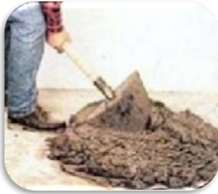
Figura 4.3 Forma clásica de revolver un mortero cemento arena y agregado grueso.
