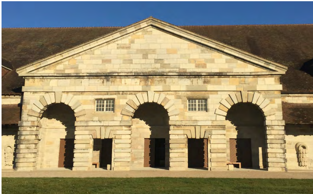
Edificio para la cocción de la sal con almohadillados en los arcos y alrededor de los vanos. Se observa la inspiración palladiana de Ledoux.
