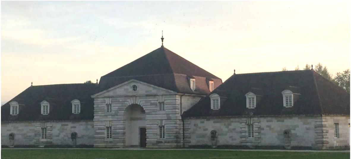
Hangar oeste (Berne, sala de calderas) de la Salina real de Arc-et-Senans.
