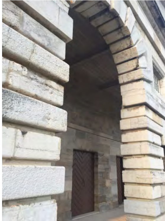
Detalle del edificio para la cocción de la sal con almohadillados en los arcos y alrededor de los vanos, reminiscencia manierista.
