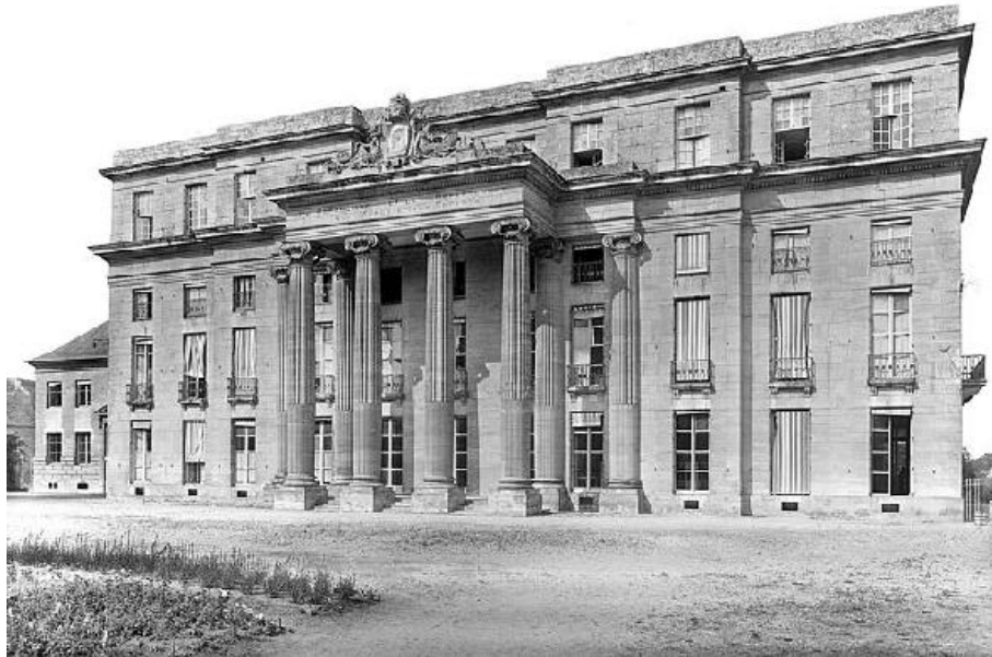
Château de Bénouville (1768-1777), Caen, Normandía. Fachada principal.
