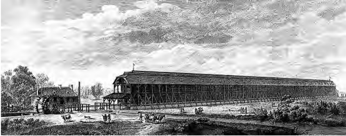
Vista del edificio de graduación de la Salina de Chaux. Lámina 9 de La Arquitectura... El edificio tenía 496 m de largo por 7 m de altura.
