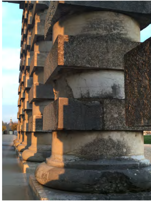
Columnas con secciones cuadradas y circulares de la casa del director de la salina.
