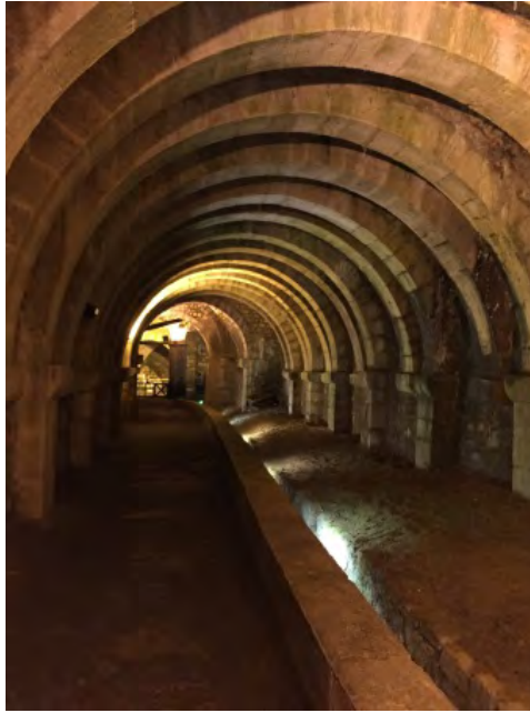
Conducción de la salmuera en la salina de Salins les Bains.
