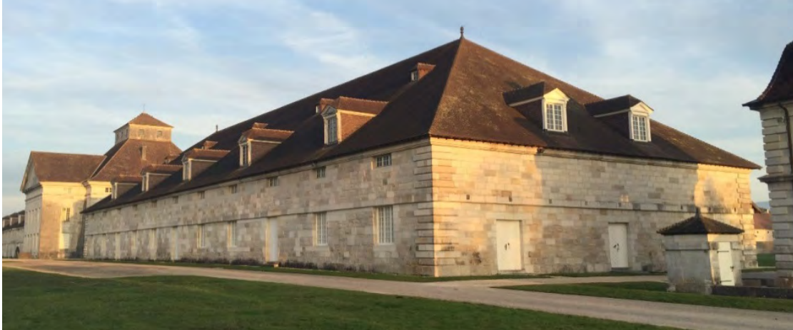
Los distintos pabellones están cubiertos por techos inclinados con teja, fabricación tradicional de la región del Franco-Condado.
