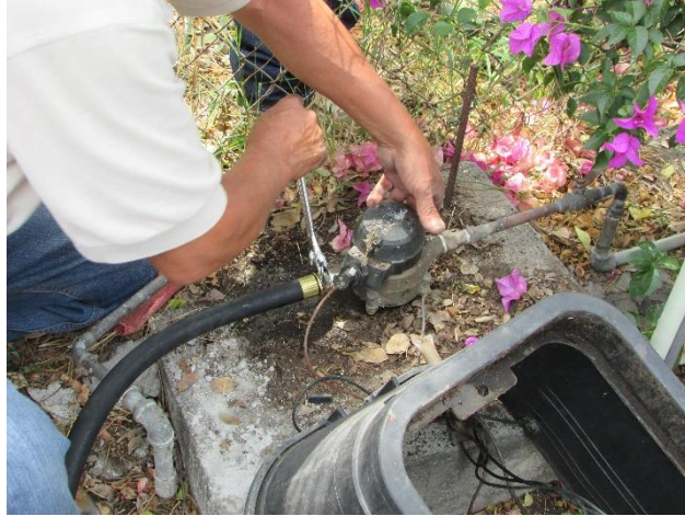
Figura 29: Aforo de medidores volumétricos en tanques de almacenamiento en la entrada de los edificios.
