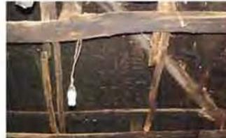
Esquina de la estructura cubierta a cuatro aguas, donde se observa la cama de carrizo sobre la que se coloca tierra húmeda para asentar la teja; en el interior de la vivienda no hay cielo falso.
