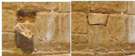
BALDOSAS DE CERÁMICA ARTEZANAL, DE 28 cnt. POR LADO Y 4 cnt. DE ESPESOR
