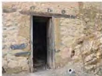
Detalle de la puerta de acceso a la habitación construida en piedra de canto rodado y juntas de tierra, que sirve de bodega. Sobre el dintel de la puerta se observan las vigas que soportan el entablado del piso superior.
