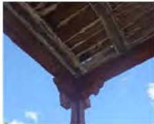
Entrepiso con entablado de madera visto desde el portal de la planta baja y acople de las monteras.
