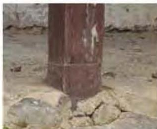
Pilar con el sistema de caja y espiga ensamblado sobre poste de madera de hualtaco que se introduce un metro en el muro de cimentación de piedra.
