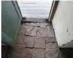
Vista desde una habitación, en la que se observa el cambio de recubrimiento de en el piso, de baldosas de cerámica a entablado de madera sobre el portal, que obedecen a dos sistemas constructivos distintos.
