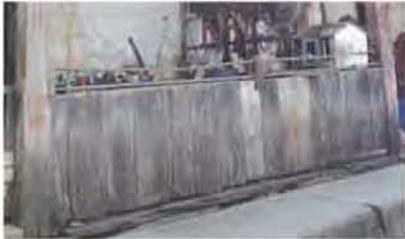
Pilares del portal ensamblados sobre la viga de arrastre, que rodea toda la edificación, sobre la cual se sustentan los muros de bahareque.
