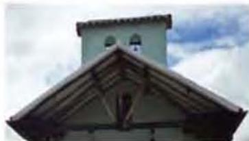
Campanario de adobe y detalle del armado de la cubierta en el atrio de acceso a la capilla.
