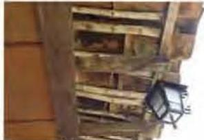
Alero sin recubrir con cielo raso en el portal, que permite observar el sistema constructivo de la cubierta en madera y tiras pareadas de carrizo, con teja asentada directamente sobre éstos
