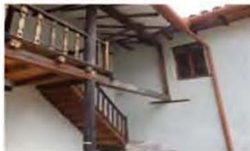
Detalle en que se evidencia el acoplamiento de la capilla a la casa de hacienda, la viga del soportal de la casa se sustenta sobre el muro portante de la capilla.
