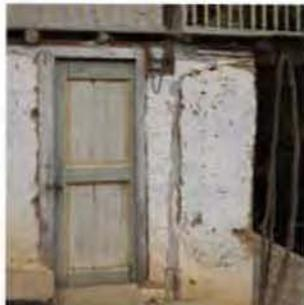
Pilara con montera y base de madera incrustado en el muro de adobe.
