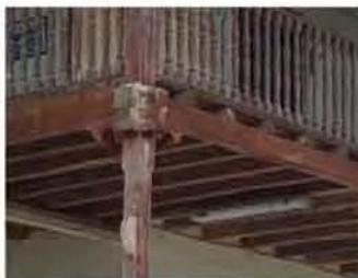
Detalle de la unión de las vigas soleras y las monteras, así como del entrepiso de madera presente en toda la planta alta.
