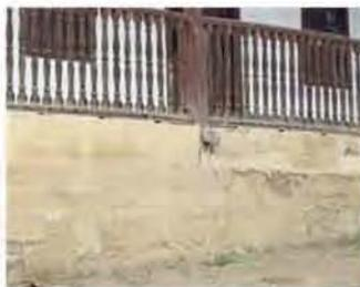
Muro de piedra recubierto con mortero de cemento y arena, donde el pilar encaja en un poste de madera de hualtaco que se pierde en el muro.
