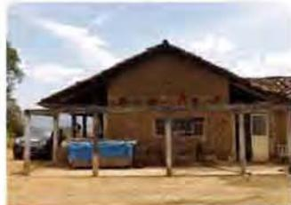
Cubierta de la sección transversal vista desde la fachada posterior donde se observa el muro de adobe sin revestir. Hilera de columnas y viga en hormigón para un portal sin concluir.
