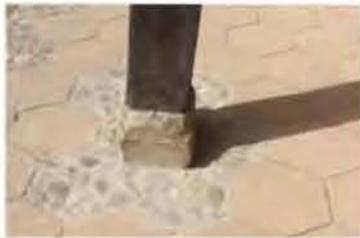
Pilar ensamblado con sistema de caja y espiga sobre piedra basa tallada.
