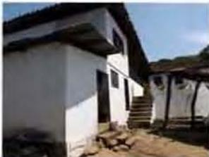
Gradas de acceso lateral entre la sección de la casa que se reconstruyó con ladrillo cocido y muro de contención que delimita el jardín de la entrada principal.
