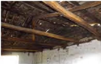
Vista interior de la estructura de la cubierta, las vigas descansan directamente sobre el muro de adobe y sobresalen en la fachada lateral .
