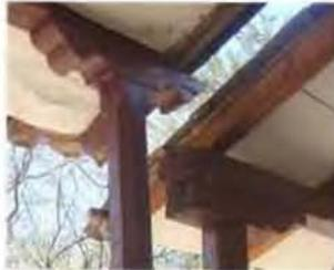
Diferencia de alturas en el acoplamiento de las cubiertas de dos fases constructivas de la edificación, que se evidencia en mayor medida por el cambio de diseño de la montera.
