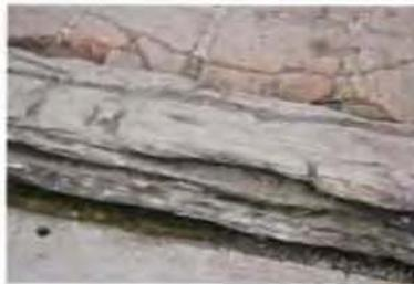
Piso con recubrimiento de baldosas de cerámica sobre tierra, delimitada por viga de arrastre en el portal.
