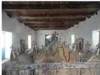
Vista posterior del retablo, no adosado a la pared, construido en madera y policromado. Cielo raso en madera de chonta que corre sobre las bigas que descansan sobre los muros y soportan la cubierta.
