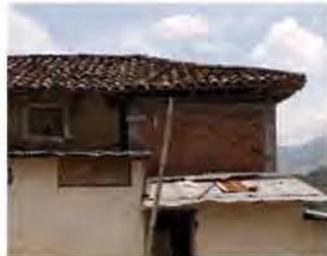
Vista posterior en la que se observa sección reconstruida con ladrillo junto a muro de adobe de doble hilera paralela que está presente en toda la casa.
