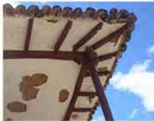
Cielo raso de carrizo y revoque de tierra y cal sobre el portal de la planta alta.
