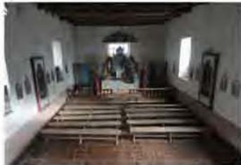
Vista del interior de la capilla construida con muros portantes de tapial y adobe; la cubierta es de estructura de madera y teja; el piso está cubierto con baldosas de cerámica artesanal.
