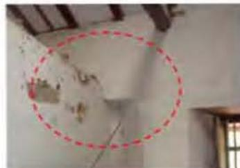
Muro a menor altura que se levantó con la finalidad dividir el espacio interior, formando un corredor. En la imagen se observa que el vano de la puerta de entrada era de mayor dimensión.
