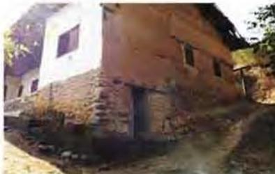
Desnivel del terreno salvado con la construcción de un muro de piedra que hace de cimiento de los muros de tapial. En esta esquina del muro se ha generado una habitación bajo el nivel del resto de la edificación.
