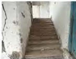
Muro de adobe sobre el que se proyecta la escalera de acceso a la planta alta. Los escalones de la escalera están contruidos en madera y el descanso recubierto con baldosas cerámica rústica.
