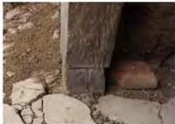
Pilar sobre poste de madera de hualtaco. El piso está recubierto con argamasa de cemento y arena, muy deteriorado.
