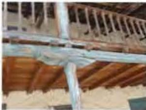
Pilares con montera tallada y entrepisos del soportal con entablado colocado directamente sobre las vigas de madera.
