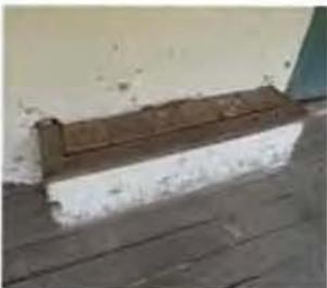
El *poyo* es un mueble fijo construido en adobe y recubierto en el lado superior con madera y baldosa de cerámica rústica. Presentes en el portal y soportal, en este último caso sobre el entablado de madera como se muestra en la imagen.
