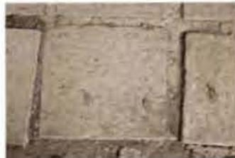
Detalle de baldosa de cerámica asentada sobre el piso de tierra, este tipo de recubrimiento está presente en toda el área de la casa que no está sobre la planta baja.
