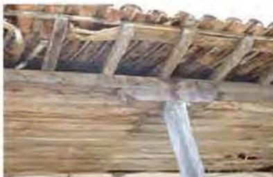
Portal con un solo pilar con montera sencilla sobre el cual corre una biga solera que descansa sobre los muros laterales de tapia soportando la cubierta de madera y teja artesanal, el cielo raso está compuesto por un entablado de madera.
