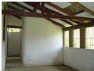
Detalle del armado de la cubierta y del portal que se serró con el fin de evitar la circulación de viento en esta zona.
