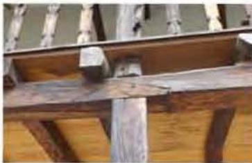
Pilares sin montera y entrepisos del portal con entablado de madera colocadas directamente sobre las vigas
