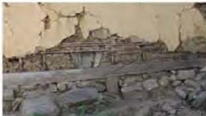
Sistema constructivo de bahareque expuesto por el deterioro, sobre viga de arrastre sustentada en poste de madera de hualtaco y cimiento de piedra.
