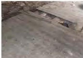
Sistema de entablado sobre vigas colocadas directamente en el piso de tierra.
