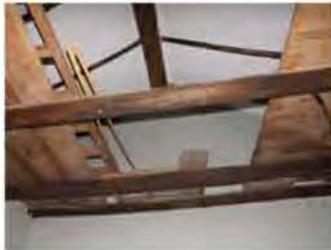
Detalle de la estructura de la cubierta en el interior de la casa donde se conserva el sistema constructivo de empañetado sobre carrizo.
