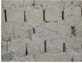
Es el sistema de trabado más común en las casas de adobe, se trata de un aparejo donde se alternan una hilada con los adobes dispuestos en tizón y en la siguiente hilada, dos hileras con los adobes dispuestos en sogá.
