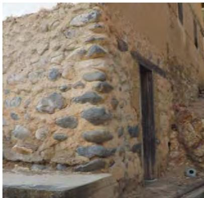
Se usa en todas las edificaciones como cimiento para todos los muros descritos, sin embargo en el sector de Casanga se salva la irregularidad del terreno construyendo un muro de piedra hasta obtener un muro a nivel que permita la edificación de las paredes en otros sistemas constructivos, en este proceso se generan pequeñas habitaciones de paredes de piedra en los sitios con mayor desnivel que sirven a su vez de muros portantes. Este espacio se usaba como bodega y/o calabozo.
