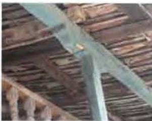
Pilar, montera y viga del soportal sobre la que descansa la cubierta en la que se observa la estructura de madera y la teja asentada directamente sobre ésta.
