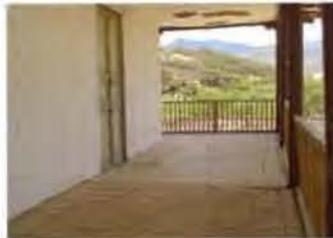
Cambio de altura de la planta baja que se refleja en los recubrimientos del piso de la planta alta, de baldosa de cerámica sobre tierra en el portal a entablado de madera en el soportal.
