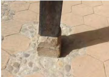
Es el sistema más utilizado durante la colonia, donde la piedra -que puede ser tallada o no- soporta el pilar de madera, mediante el sistema de caja y espiga, y lo aísla de la humedad.
