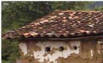
Orificios de ventilación en el muro de la cocina.
