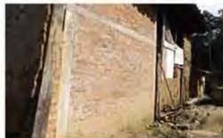
Pérdida del sistema constructivo original, columnas de hormigón con mampostería de ladrillo que reemplaza una sección de la pared de bahareque.
