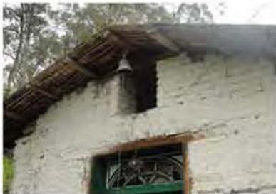
Detalle en el que se observa dos sistemas constructivos: tapial y adobe de doble hilera cruzada. La introducción del adobe permite seguir la pendiente de la cubierta.
