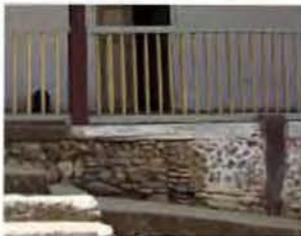
Pilar ensamblado en la viga de arrastre que corre sobre el muro de cimentación, y que se consolida con el mismo mediante un poste de madera.
