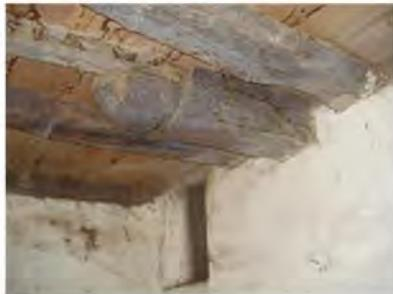
Vista interior del acoplamiento del muro y del entepiso de madera que está presente sobre toda el área de esta planta.
