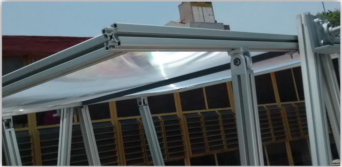
Figura 4.1. Juntas con giro sin manija para los sostenes de la canasta central y perfiles del marco unidos con escuadras internas ajustables
