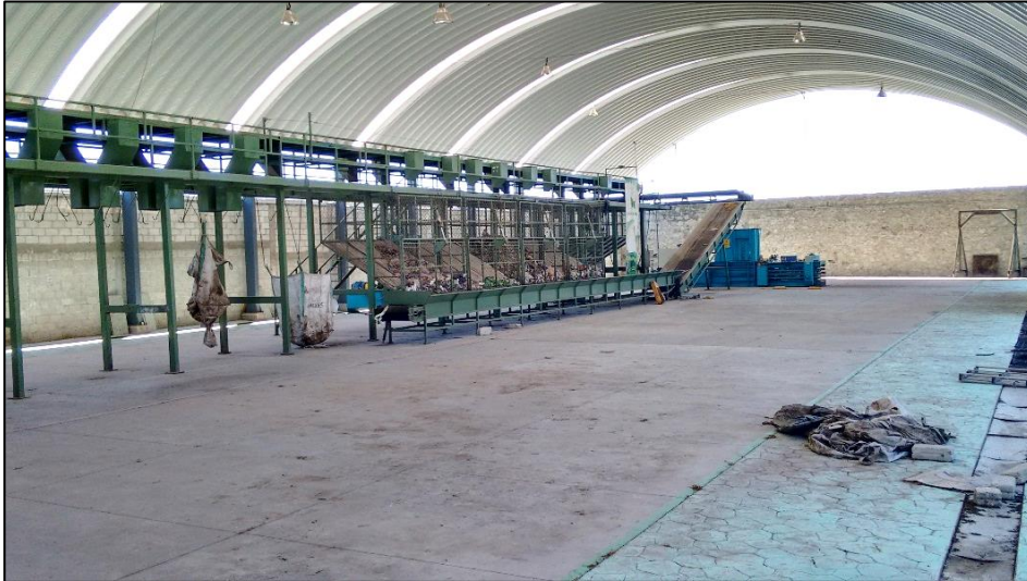
Figura 5.12 Planta de separación de residuos “Cambio Verde” Fuente: (Elaboración propia)
