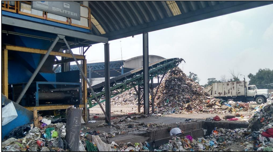
Figura 5.29 Separación de la materia orgánica por el separador tipo Splitter Fuente: (Elaboración propia)
