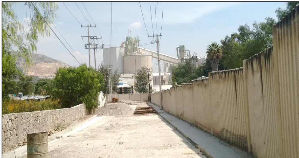
Figura 5.9 Cementos Fortaleza Planta Vito Fuente: (Elaboración propia)
