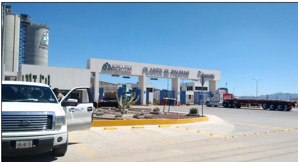
Figura 5.8 Cementos Fortaleza Planta El Palmar Fuente: (Elaboración propia)
