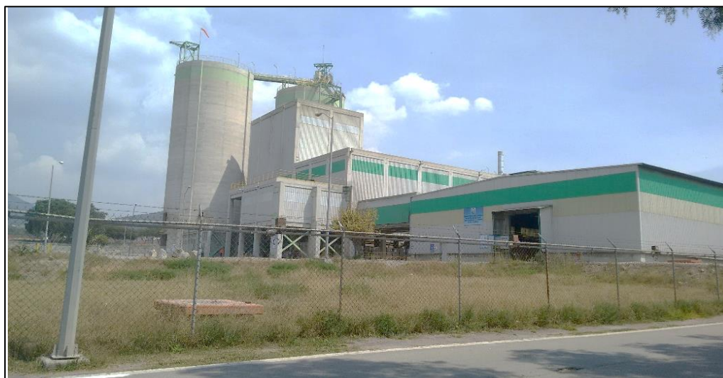
Figura 5.10 Cementos Fortaleza Planta Tula Fuente: (Elaboración propia)
