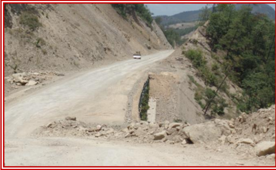
Km 0+000 E.C. Carretera Mitla – Tehuantepec II
