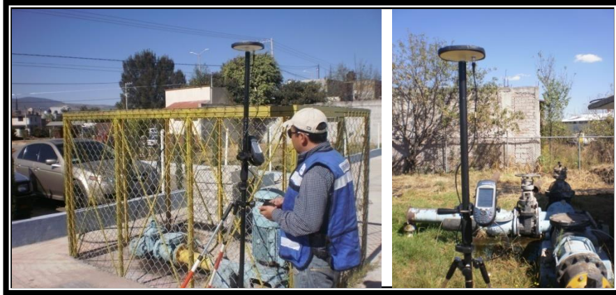
Foto 5.7. Toma de elevación con GPS
