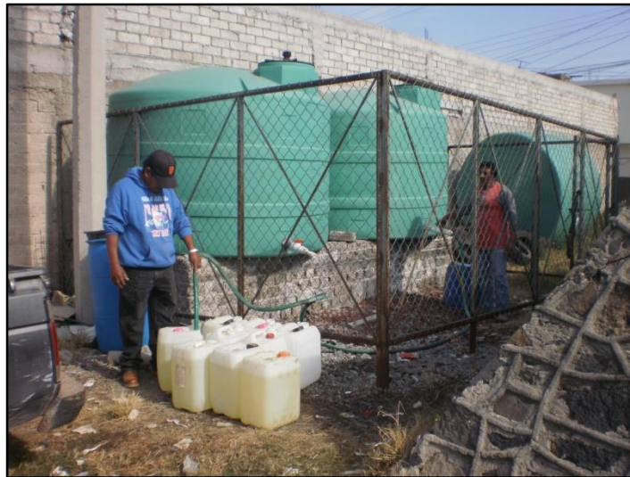
Foto 5.4. Depósitos de Hipoclorito generales para su posterior traslado a cada tanque.
