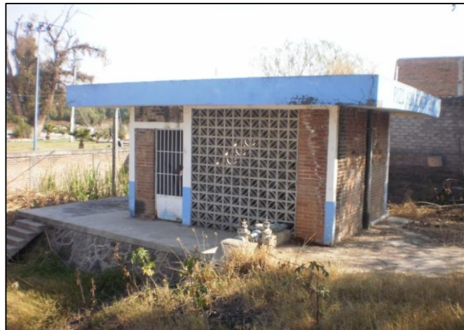
Foto 3.5. Captación “Agua Bendita”
