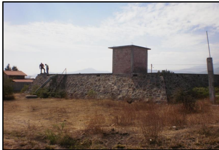
Foto 5.2. Tanque Loma Alta
