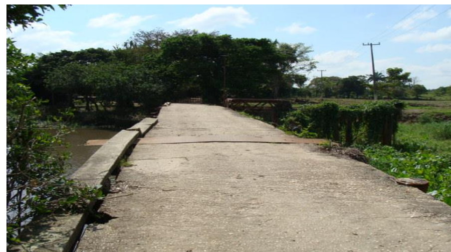
PUENTE HACIA ZONA DEPORTIVA VISTA OESTE
