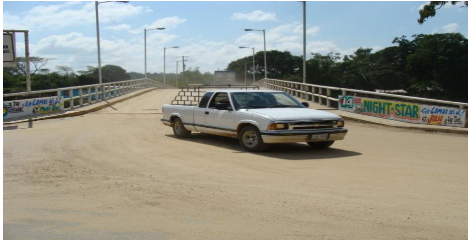
ENTRADA A ZONA DEPORTIVA VISTA OESTE
