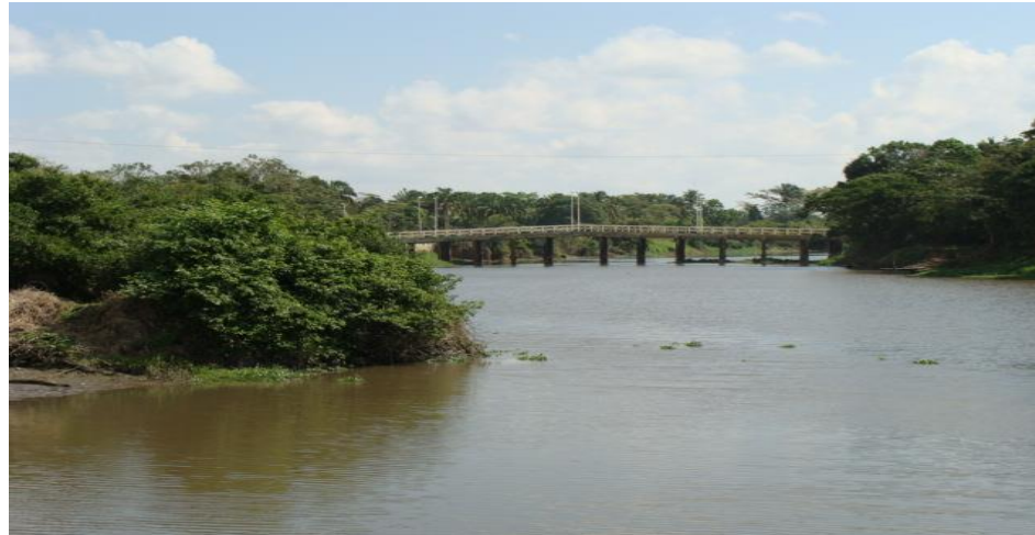
PUENTE QUE COMUNICA A AREA SOCIAL CON DEPORTIVA. VISTA NORTE
