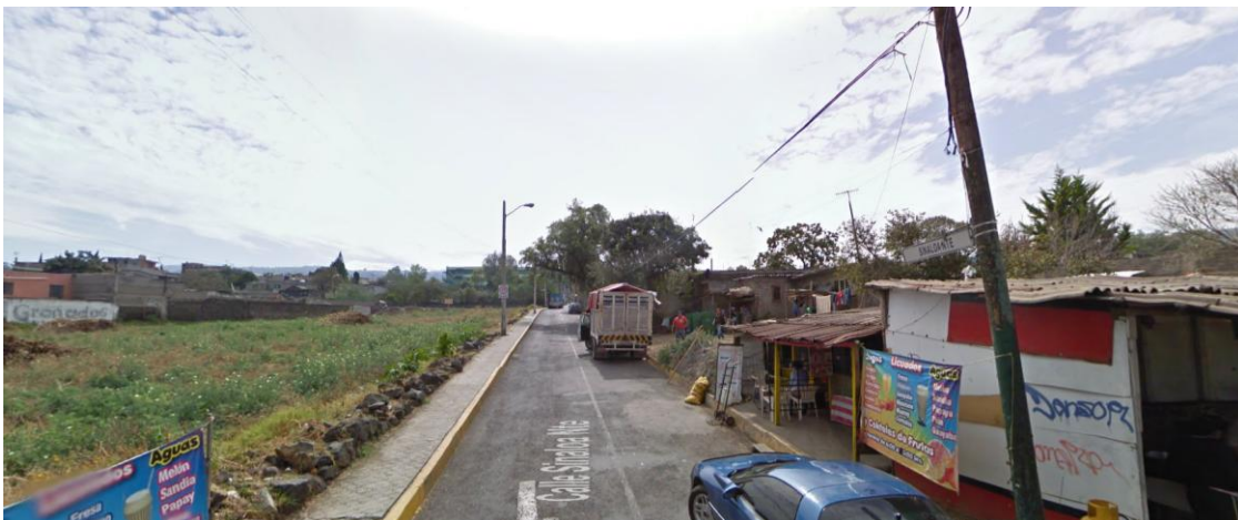
Construcciones realizadas a base de tabique y láminas de cartón.
