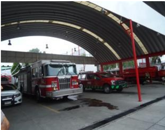
Vista hacia vehículos de emergencia.
