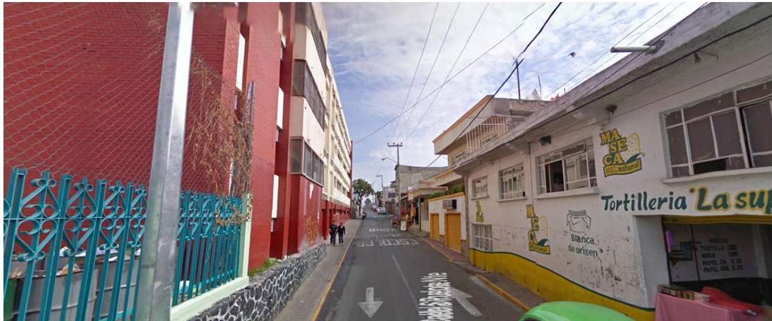
Construcciones sobre calle Puebla Poniente.
