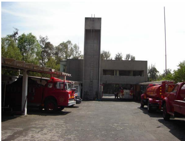
Parte posterior de la Estación, se utiliza para maniobrar los autos de emergencia y estacionarlos.
