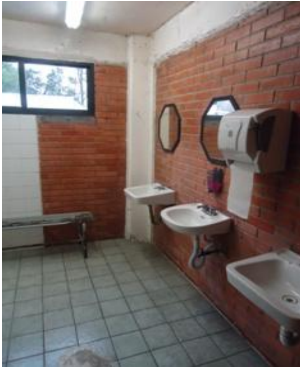
Vista de lavabos en sanitarios hombres.
