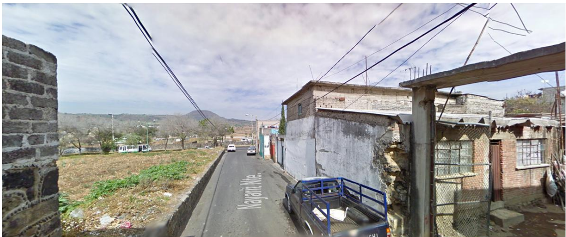
Construcciones sobre Nayarit Norte hechas con lámina de asbesto. Algunas construcciones sin aplanado tienen como acabado pintura.
