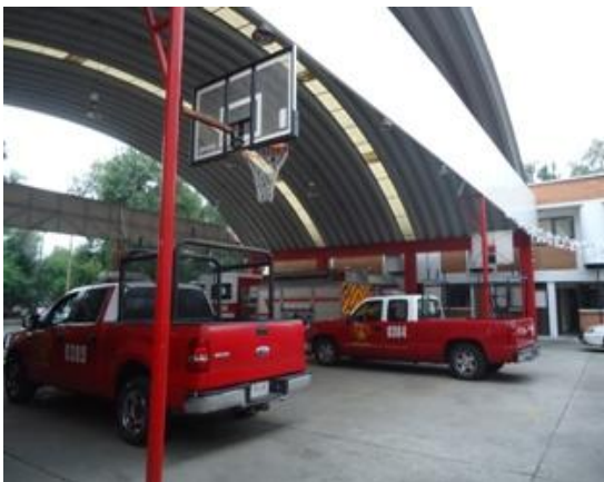
Vista hacia vehículos de emergencia, se observan tableros de basquetbol.
