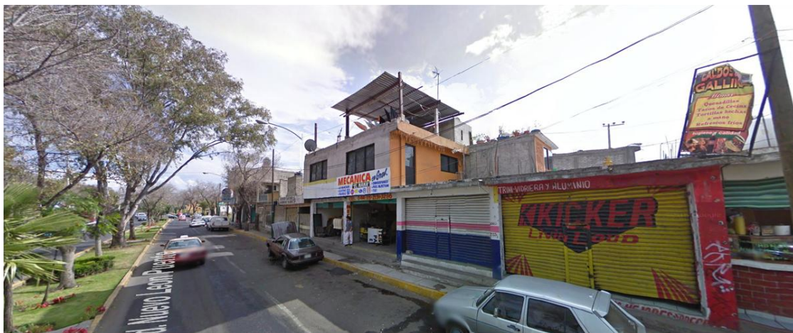
Construcciones con losa de concreto armado pero escaso diseño de espacios.
