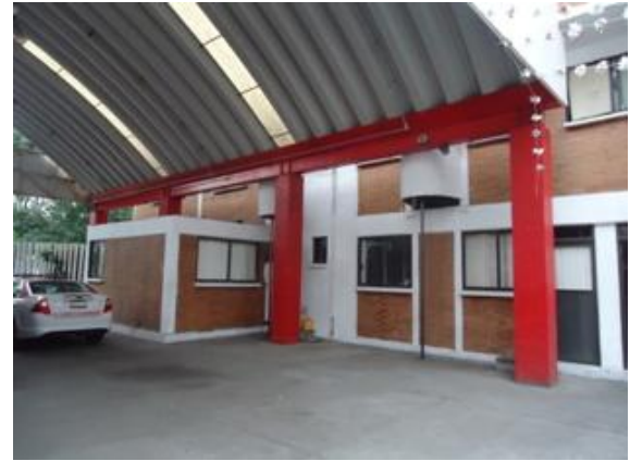
Vista hacia zona administrativa y dormitorios, se observan postes de deslizamiento y timbres.
