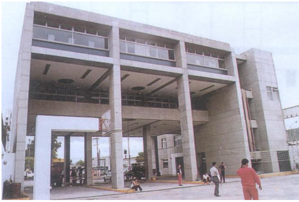
Vista trasera de la Estación.
