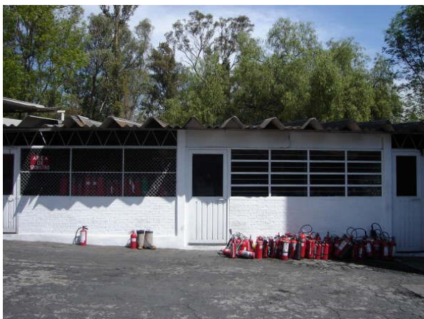
Bodega en parte posterior para guardar diversos objetos como cilindros, extintores, etc.
