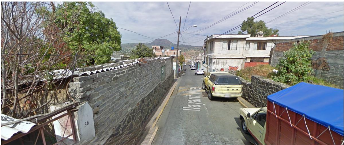
Construcciones sobre Nayarit Norte hechas con lámina de asbesto.
