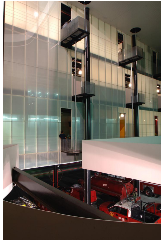
Postes de deslizamiento muy altos para ser utilizados adecuadamente.
