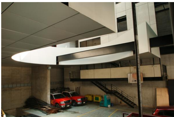
Estacionamiento de vehículos de emergencia.
