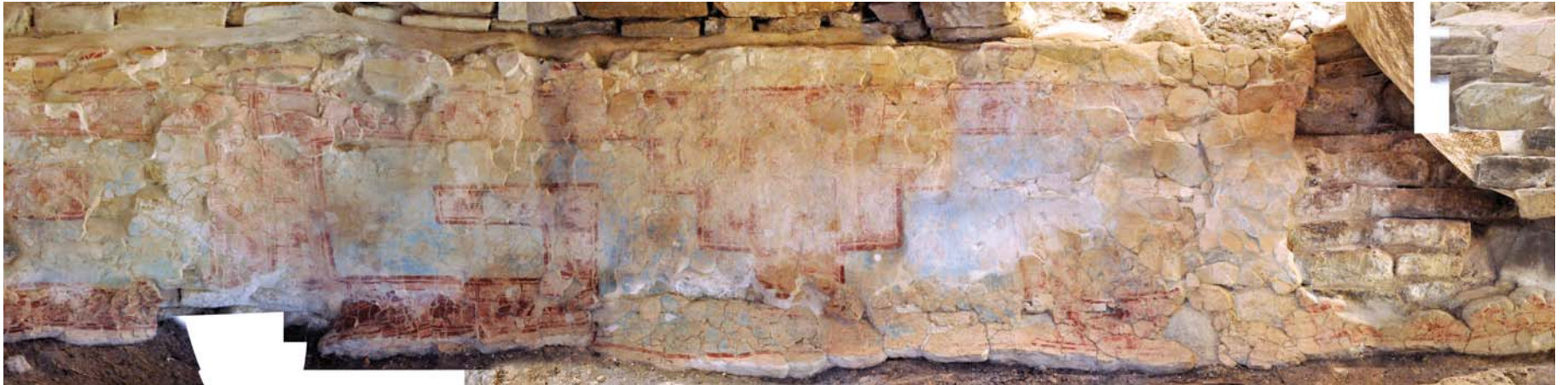
FIG.24 PINTURA MURAL DEL EDIFICIO 11 BIS EN DONDE SE OBSERVA LA IMAGEN DUAL DE LA GRECA EN TONO AZUL
