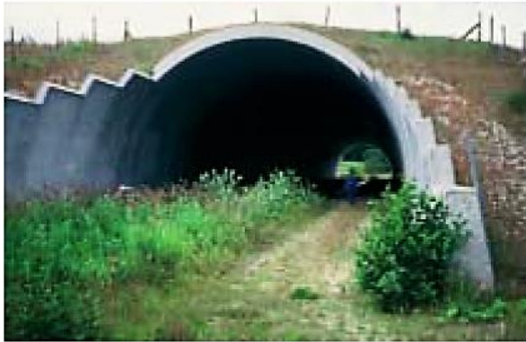
Fig. 4-37 Restitución de un camino forestal compatible con el paso de fauna silvestre. Foto: B. Wandall.
