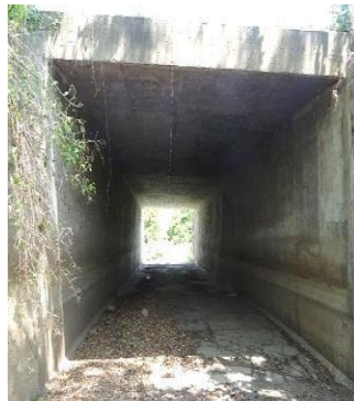
Fig. 5-3 Paso subvial tipo alcantarillo presente en el proyecto
