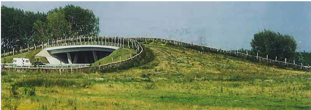
Fig. 4-22 Paso situado en un terreno llano, con rampas de ligera pendiente. Foto: P. Farkas.
