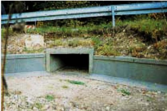
Fig. 4-67 El terreno adyacente a la estructura guía se mantiene completamente liso y libre de vegetación.
