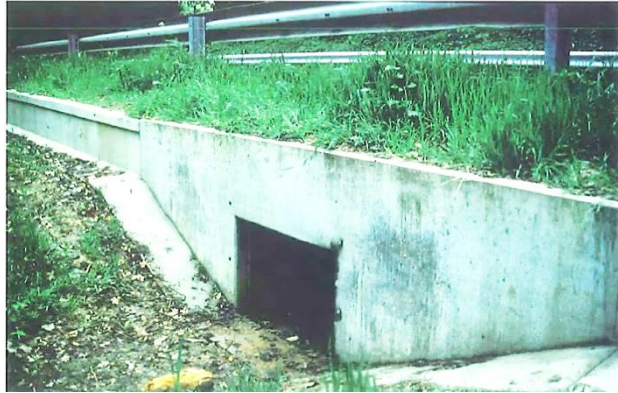
Fig. 4-63 Paso rectangular para anfibios en Alemania con estructuras bien delimitadas. Foto: J. Niederstrasser.
