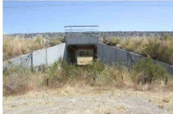
Fig. 4-40 Paso superior para pequeños vertebrados. Foto: Llorente y Diez.
