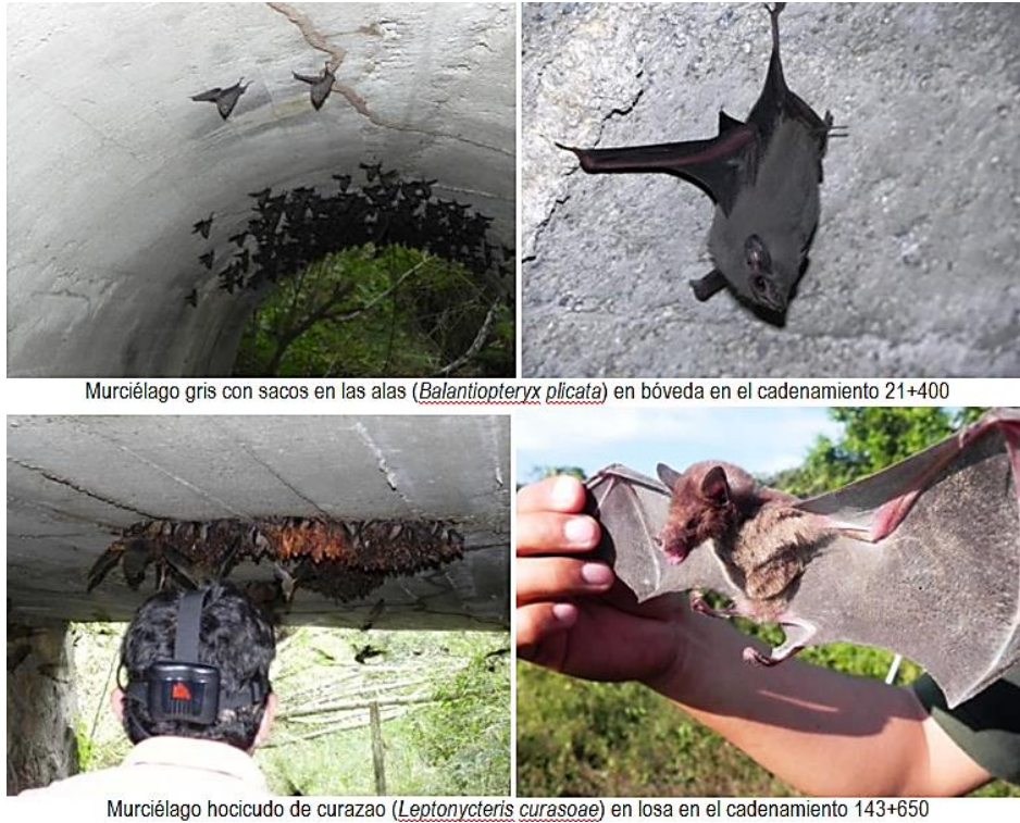
Fig. 5-28 Murciélagos encontrados en las bóvedas de las obras de drenaje. Ref. 18
