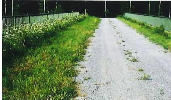
Fig. 4-24 Puente situado sobre una línea de ferrocarril de alta velocidad cerca de Oberderdingen, Alemania.
