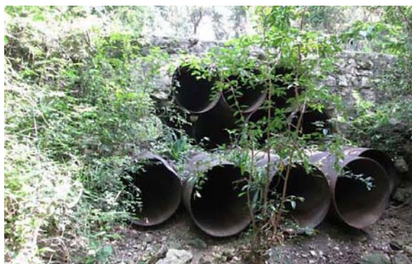
Fig. 5-12 Ejemplo de obra de drenaje conformada por 12 tubos, ubicada en el km 58+093 que podría ser reemplazada por una losa para facilitar el tránsito de fauna de talla inferior-mediana. Foto: Ref.16
