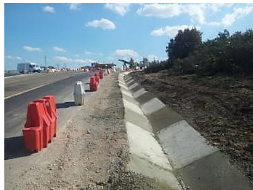
Fig. 5-23 Ejemplos de cunetas que favorecen el acceso a anfibios, reptiles y micromamíferos al entorno
