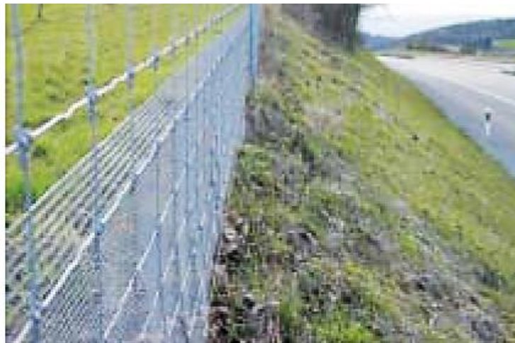
Fig. 4-43 Instalación de un refuerzo en la parte exterior de la malla convencional. Foto: C. Rosell.
