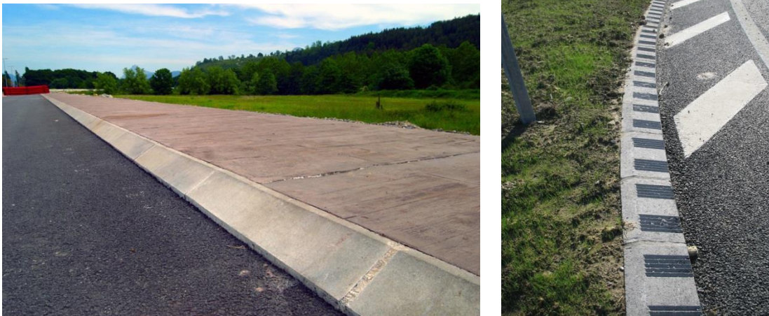
Fig. 5-24 Ejemplos de bordillos en rampa
