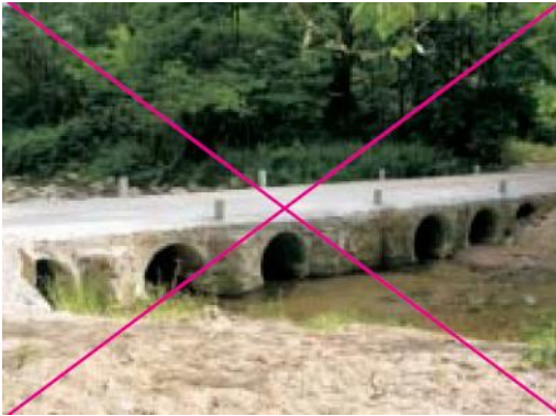
Fig. 4-62 Ejemplo 4 de malas prácticas: Drenajes situados en un badén que dificultan el paso de peces. Foto: F. Navàs.
