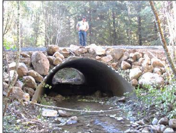
Fig. 4-56 Alcantarilla reconstruida en el Parque Nacional de Umpqua, Oregón, E. U.
