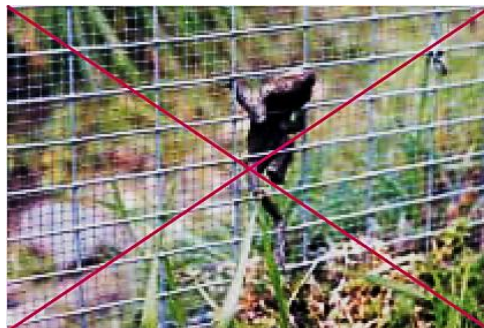
Fig. 4-65 Ejemplo 1 de malas prácticas: Para el cercado de este tipo de pasos las mallas de alambre galvanizado no son aplicables porque los anfibios intentan trepar por ellas. Foto: R. Campeny.
