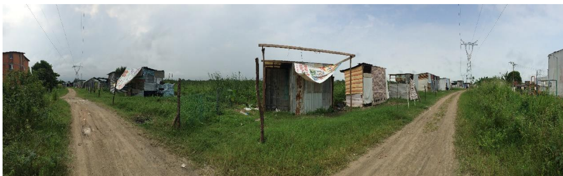
Fotografía 6. Vista panorámica del bordo de protección del vaso regulador (la calle que se observa es el bordo). Se encuentran ubicadas a orilla del bordo viviendas construidas con materiales endeables, lo que genera un riesgo para los habitantes. Fecha: 19 de diciembre de 2015.
