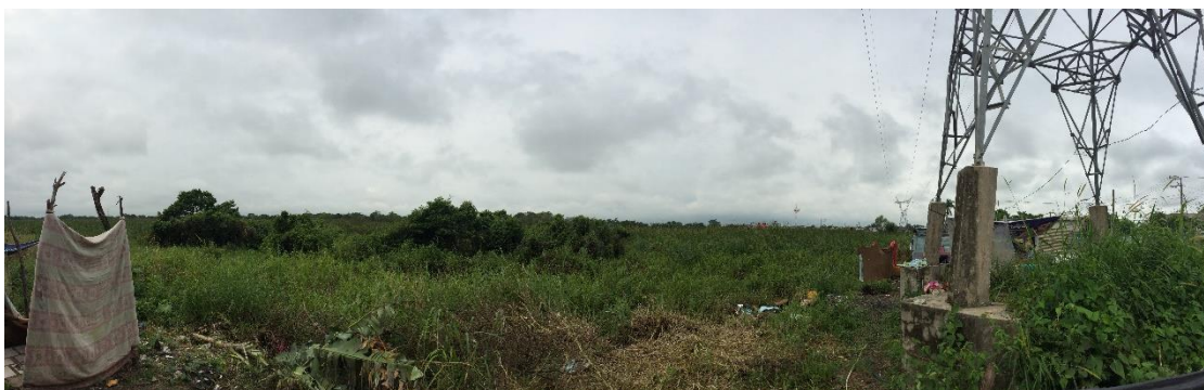
Fotografía 5. Vista panorámica del vaso regulador (o también conocida como laguna “La Lima”) ubicado en la localidad Bosque de Saloya, Nacajuca, Tabasco. Cuando el vaso regulador sobrepasa su nivel ordinario alcanza a inundar gran parte de la localidad. Se puede observar extensa vegetación. Fecha: 19 de diciembre de 2015.
