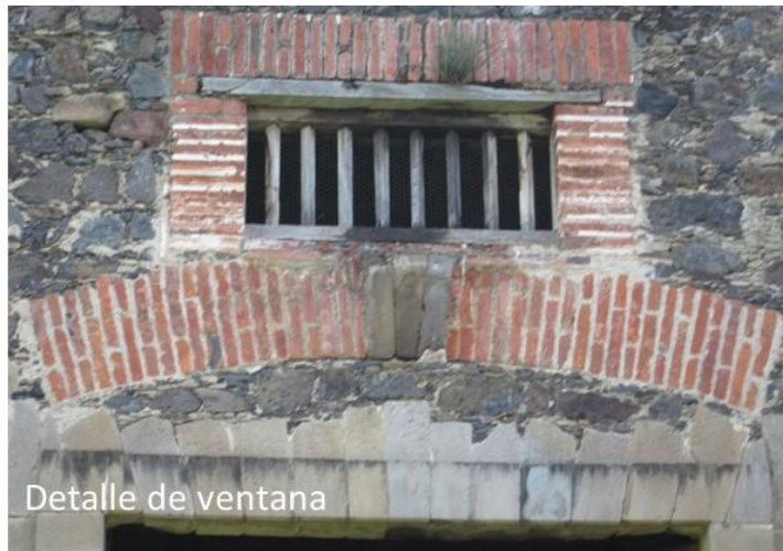
Foto 1 y 2. Detalles de algunos elementos componentes de la troje de la hacienda de Mezquite Gordo. Se aprecian las fábricas y algunos deterioros. Fotografía: NCRG/ 06-09-2015.
