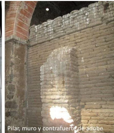
Foto 3 y 4. Muros interiores divisorios, se aprecian las diferentes fábricas con que están elaborados.
