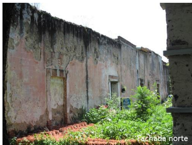
Foto 24 y 25. Fachada norte y oriente de la primera casa. Se observan los restos de aplanados, así como los fuertes deterioros generados por la humedad. Fotografía: NCRG/ 11-08-2014.
