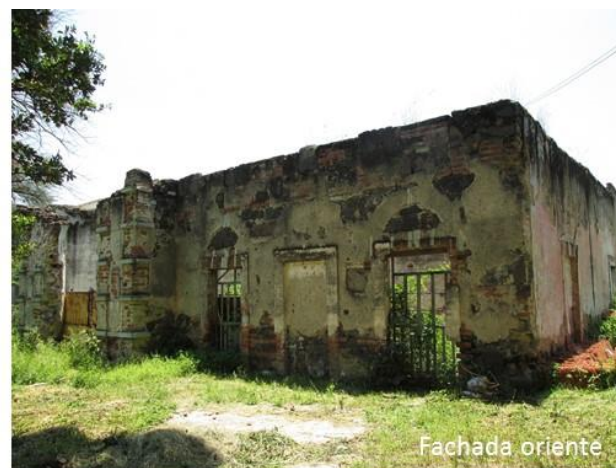
Foto 24 y 25. Fachada norte y oriente de la primera casa. Se observan los restos de aplanados, así como los fuertes deterioros generados por la humedad. Fotografía: NCRG/ 11-08-2014.
