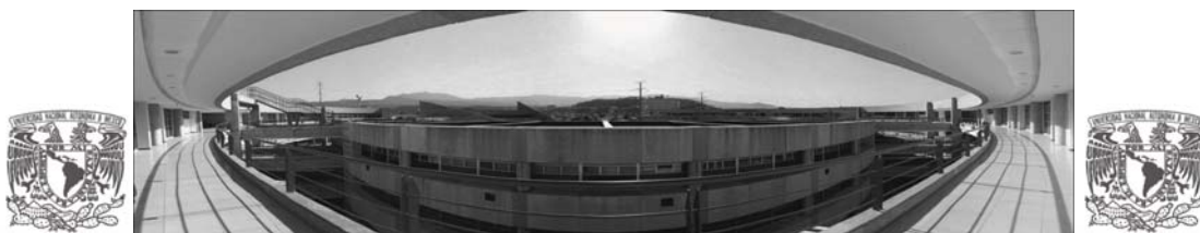
Panorámica del Edificio de Posgrado de la UNAM. “Elaboración Propia”
