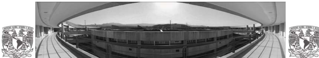
Panorámica del Edificio de Posgrado de la UNAM. “Elaboración Propia”
