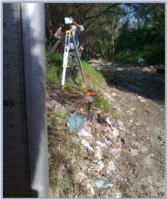
Trazo y nivelación para desplante de estructuras.
