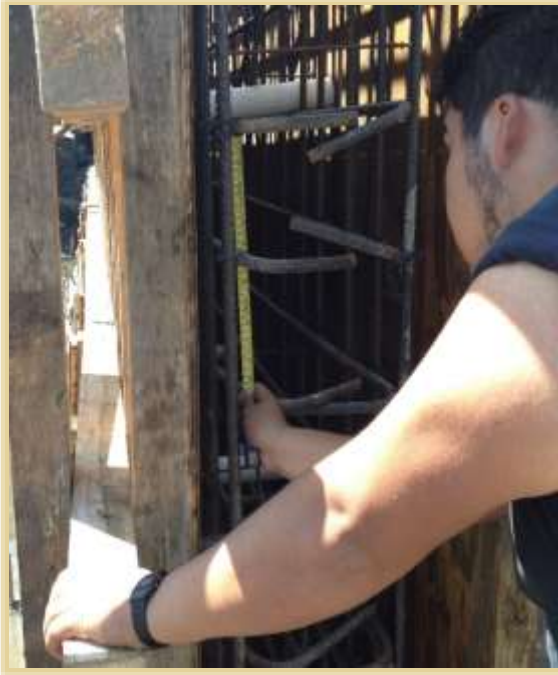
Suministro y colocación de tubo de PVC para lloraderos.
