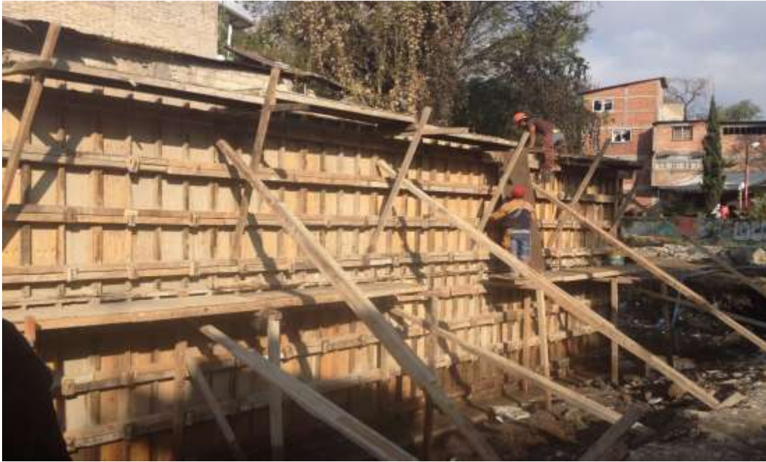
Colocación cimbra de Madera.
