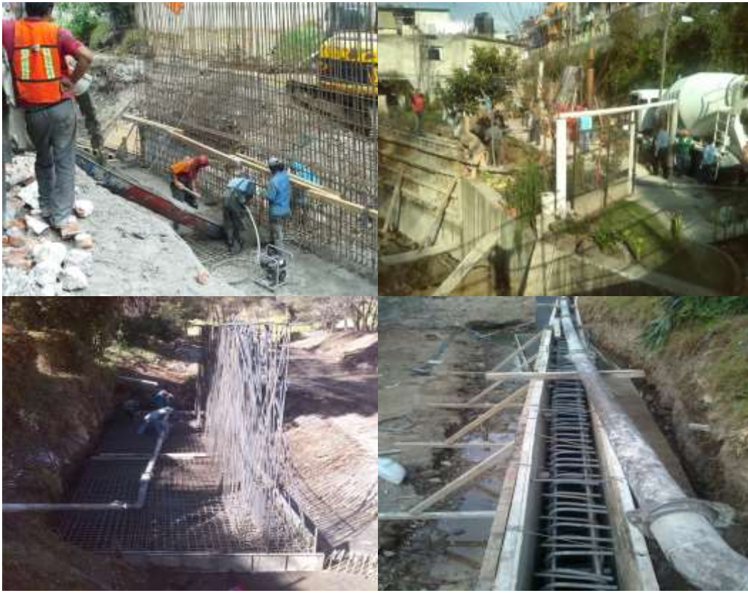
Fig. 1.36 Suministro y colocación de concreto premezclado en los km 5+520, 5+560, 5+580 y 5+788
