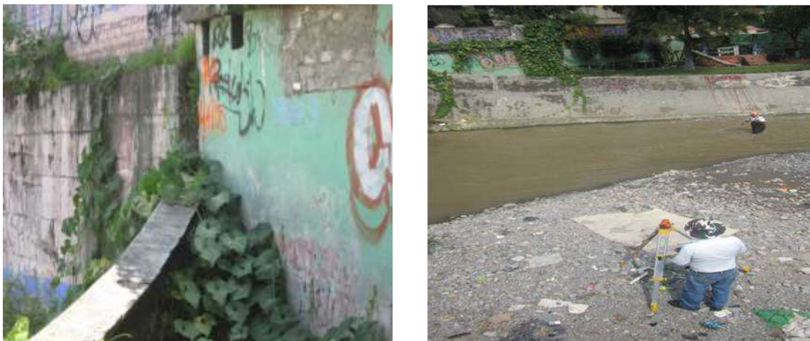
Fig. 2.14 Frente de trabajo 2 (Dos) a la altura del km 4+100, margen derecha.
