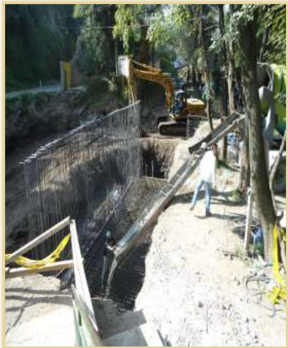
Suministro y colocación de concreto premezclado f'c=250\text{kg/cm}^2
