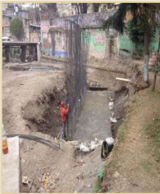
Colocación de acero de refuerzo grado 42.
