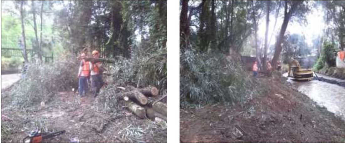
Fig. 1.22 Limpieza y deshierbe de la zona de los trabajos en el km 5+607
