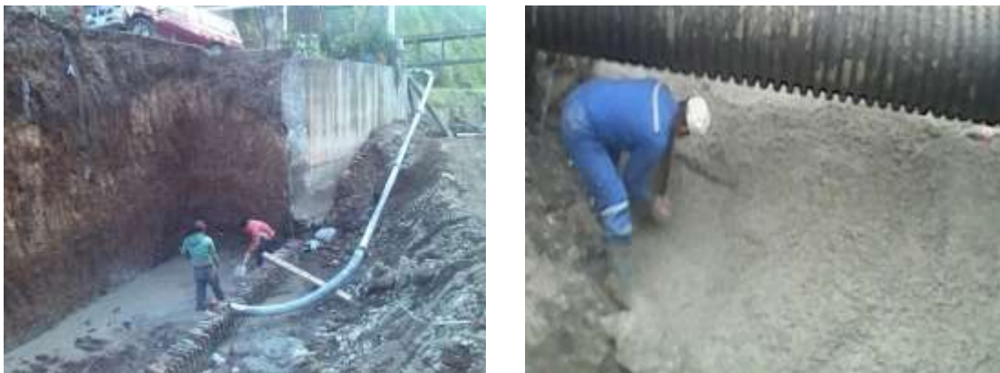
Fig. 1.32 Plantilla de concreto en los km 5+562 y km 4+120
