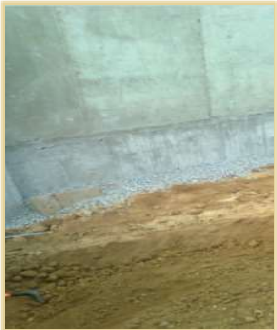
Suministro y colocación de arena y grava para formación de filtro.
