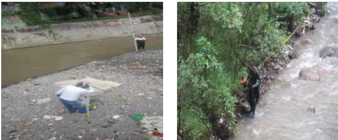
Fig. 1.20 Trazo y nivelación en el km 4+100 y 5+560
