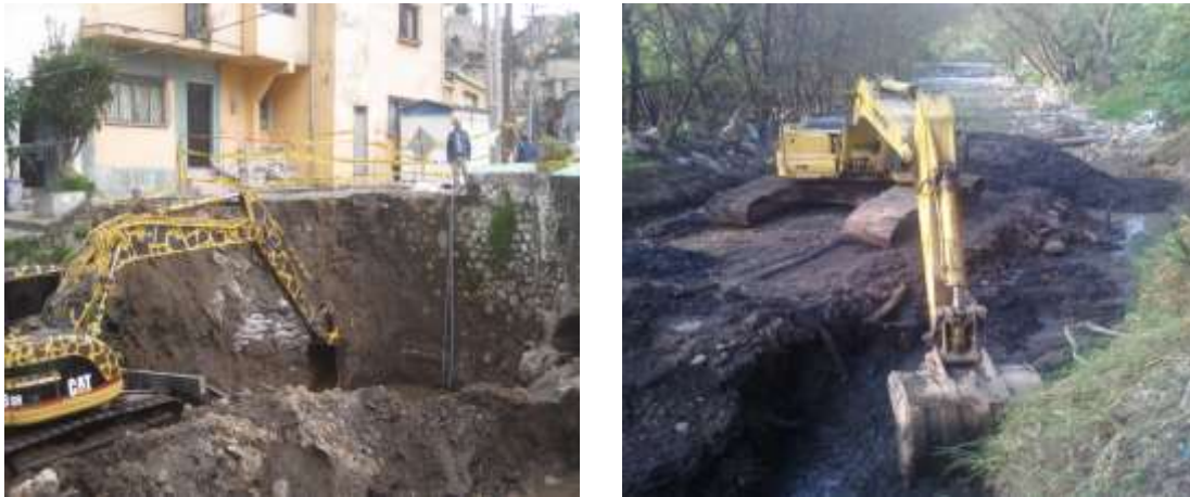
Fig. 1.26 Excavación por medios mecánicos en los km 5+ 120 y 5+808
