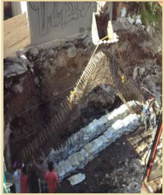
Colocación de costales rellenos de tepetate para formación de ataguía.
