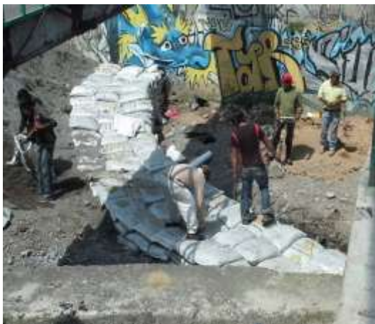
Fig. 1.30 Suministro y colocación de costales para Ataguía en los km 3+417 y 5+580
