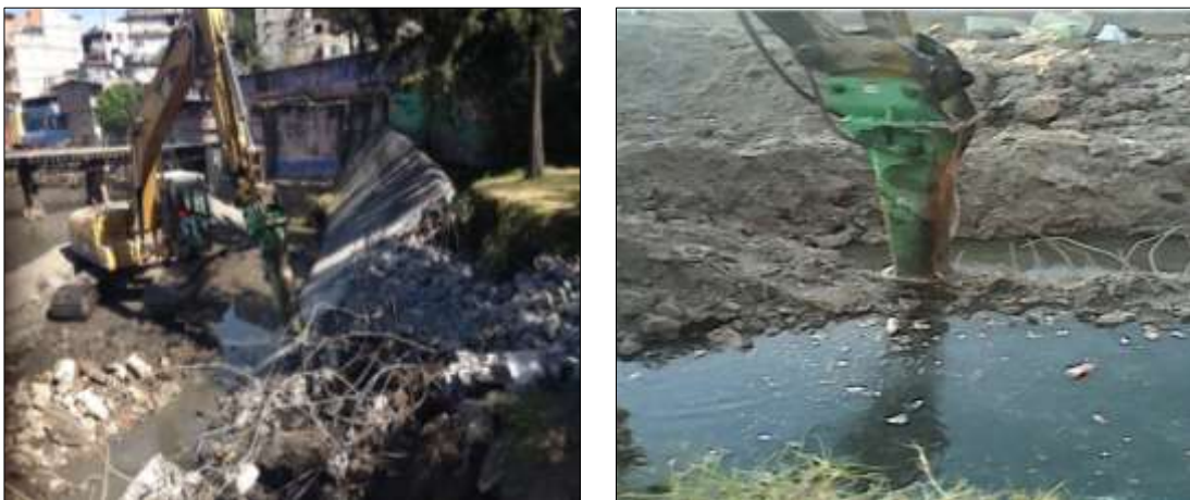
Fig. 1.24 Ruptura y demolición de elementos de concreto armado en el km 4+100
