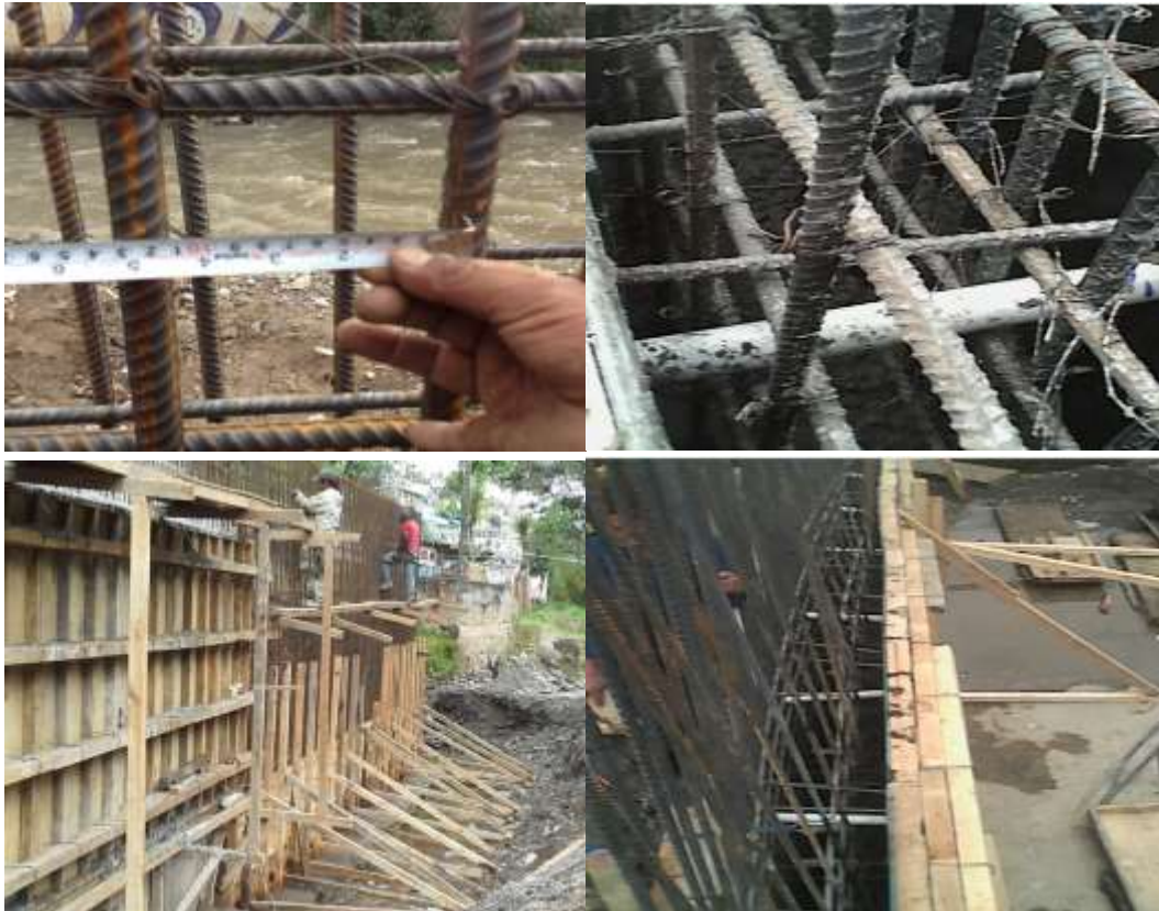
Fig. 1.34 Armado y habilitado de acero de refuerzo en el km 3+500, cimbra en el km 5+808 y lloraderos en el km 5+120
