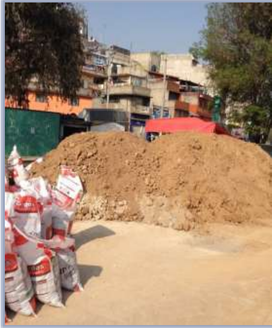
Colocación de costales rellenos de tepetate para formación de ataguía.
