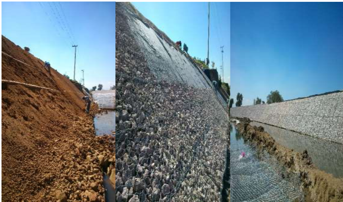
Fig. 1.13 Protección en talud del tipo semipermeable
