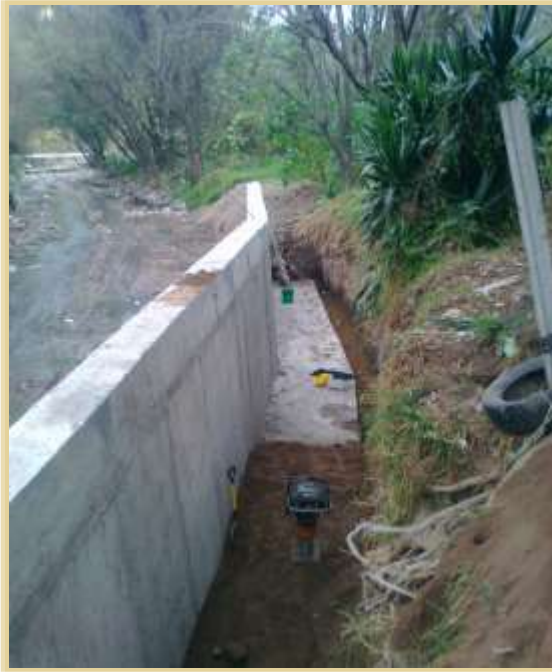
Suministro y colocación de material de banco para relleno compactado.
