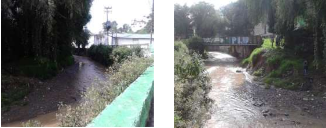
Fig. 2.9 Frente de trabajo 3 (Tres) a la altura del km 5+120, margen derecha.
