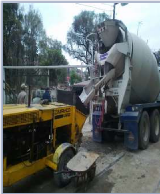
Suministro y colocación de concreto premezclado f'c=250\text{kg/cm}^2
