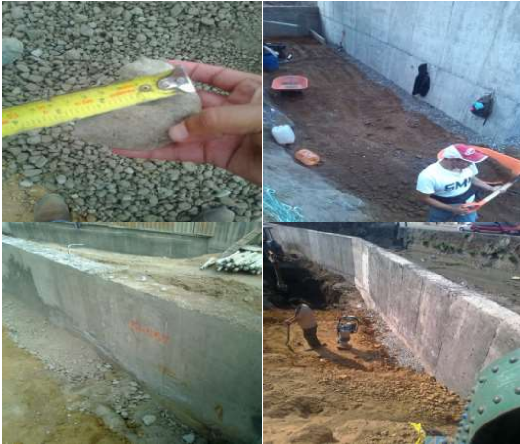
Fig. 1.38 Suministro y colocación de tepetate y filtro de arena grava en los km 3+740, 5+580 y 5+120
