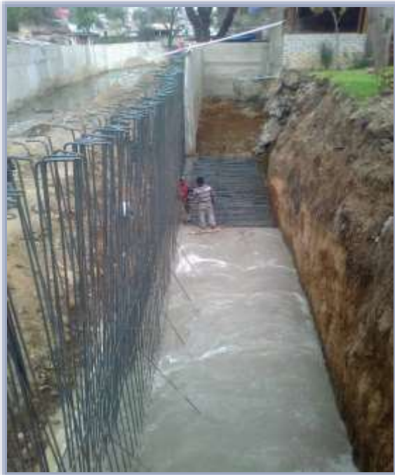
Colocación de acero de refuerzo grado 42.
