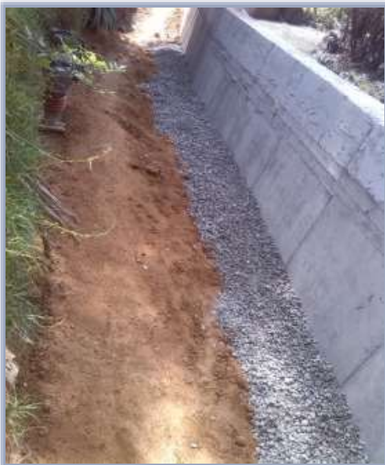
Suministro y colocación de arena y grava para formación de filtro.
