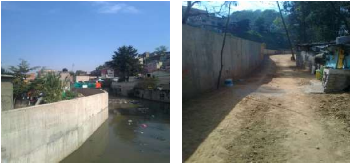
Fig. 2.5 Trabajos de obra terminados.
