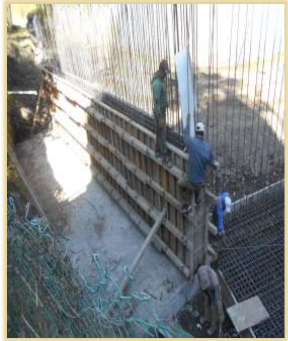
Suministro y colocación de cinta de PVC.
