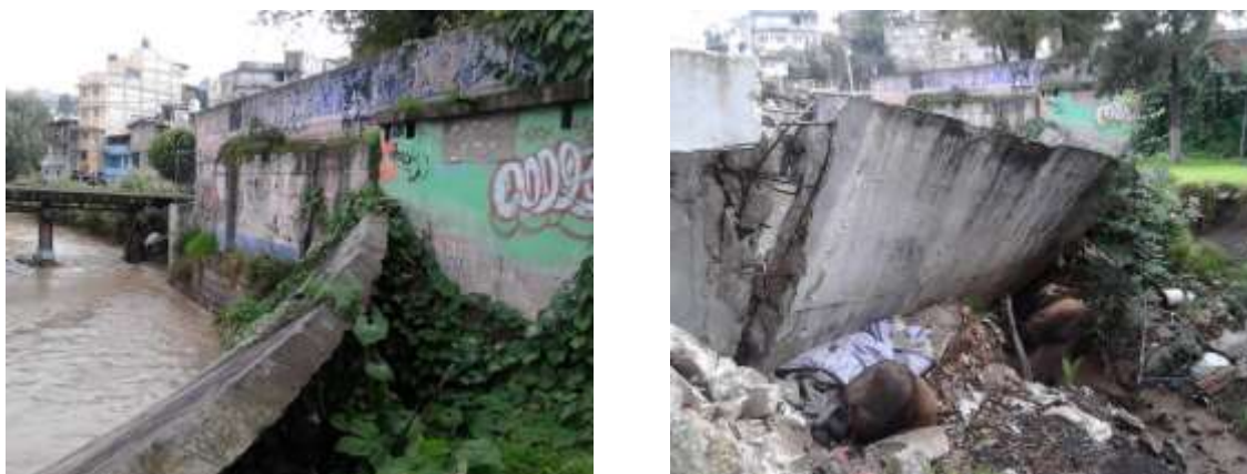
Fig. 2.8. Frente de trabajo 2 (Dos) a la altura del km 4+100, margen derecha.
