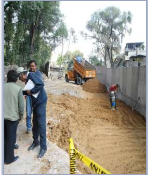
Suministro y colocación de material de banco para relleno compactado.
