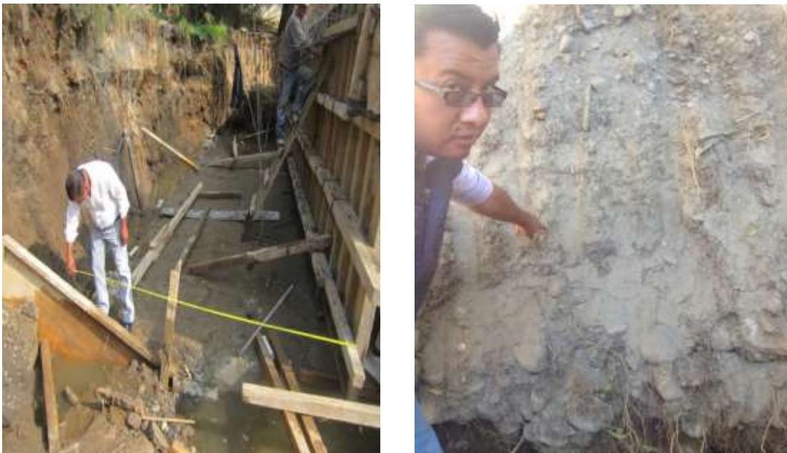
Fig. 3.10 Verificación de trabajos de excavación.
