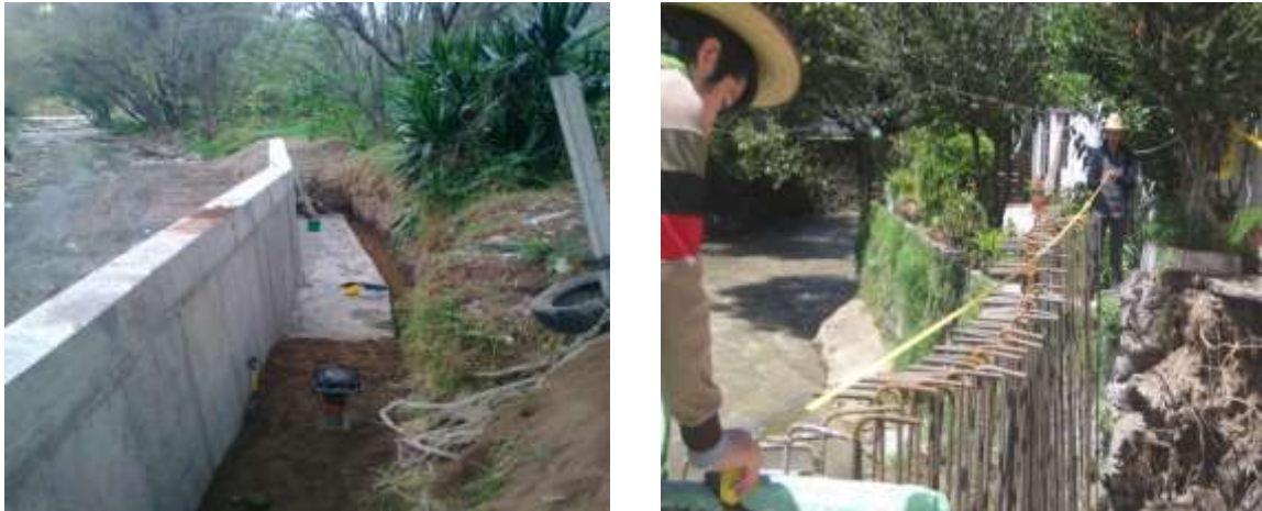
Fig. 3.2 Trabajos de relleno con material de banco (tepetate) y revisión de longitud del módulo de muro de concreto.
