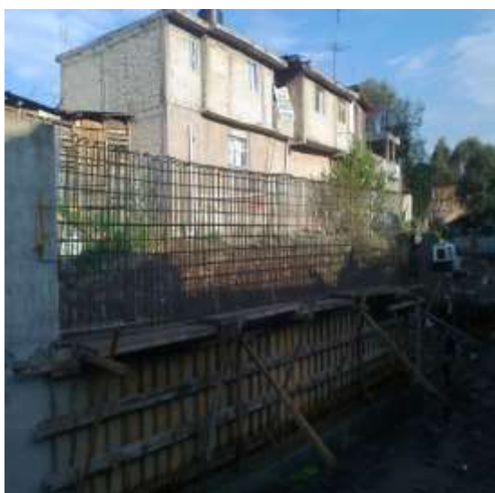
Fig. 2.3 Verificación y control de los trabajos. (Cimbra de madera y trazo y nivelación)
