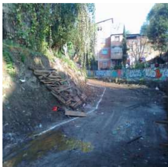
Fig. 2.3 Verificación y control de los trabajos. (Cimbra de madera y trazo y nivelación)
