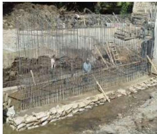
Fig. 1.30 Suministro y colocación de costales para Ataguía en los km 3+417 y 5+580
