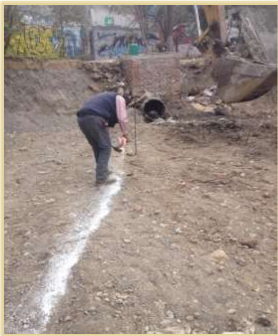
Trazo y nivelación para desplante de estructuras.
