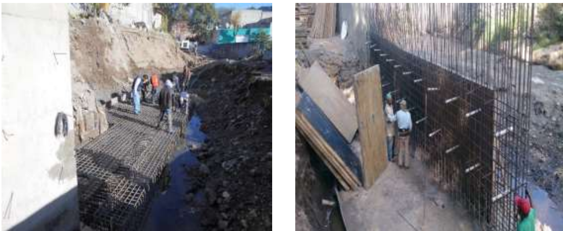
Fig. 3.1 Trabajos ejecutados de acero de refuerzo, cimbra y lloraderos.
