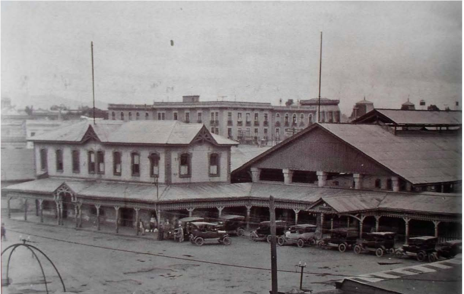
Antigua estación Buenavista Ciudad de México 1926. Fig. 75
