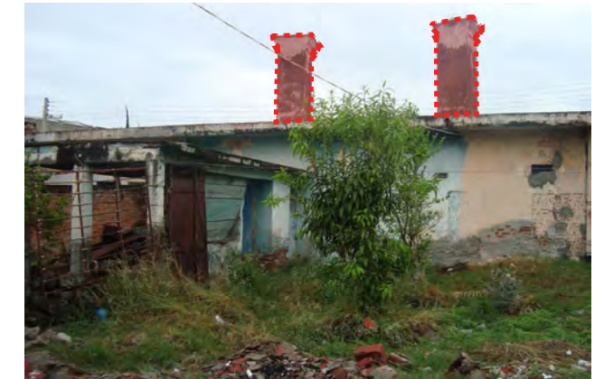
Columnas ahogadas en losa de concreto armado
