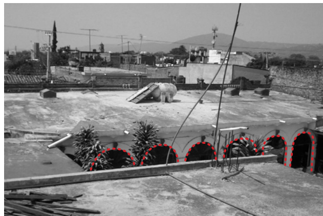
Fotografía de estado actual donde se aprecia la arcada.
