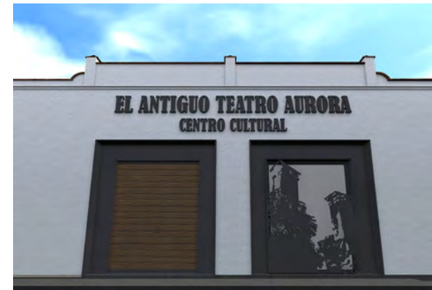
Vista de acceso principal.
