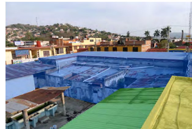
Vecindad de lámina que cega parte de las ventanas de uno de las construcciones consideradas como "históricamente meritorias".
