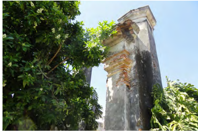
Dintel de Fachada, Fotografía de estado actual.
