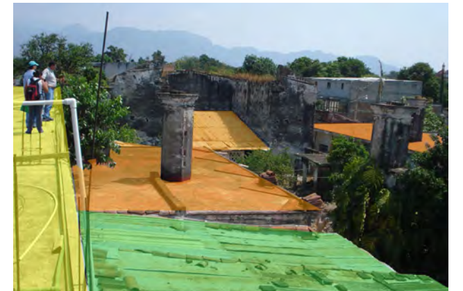
Columnas adosadas a losa de concreto armado.
