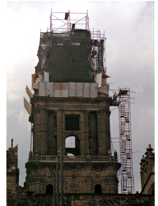
Trabajos de restauración en campanario oriente de la Catedral Metropolitana de la Ciudad de México (2007-2008).
