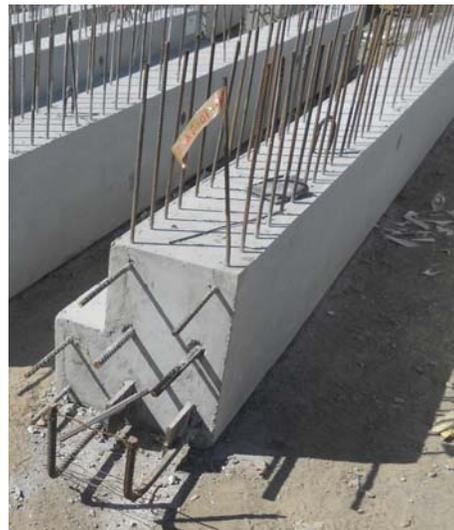
Figura 1.12 Traveses portantes de concreto prefabricadas.
