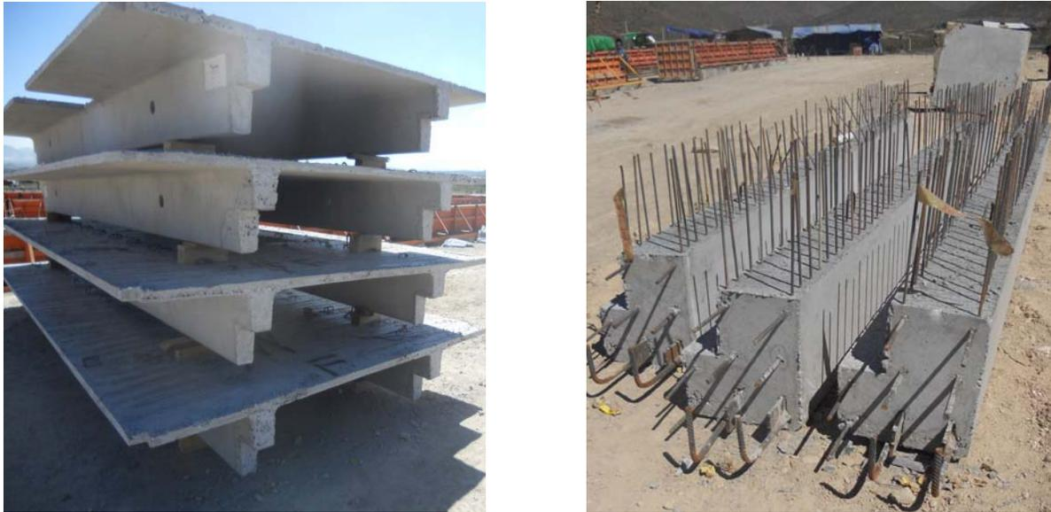
*Figura 1.32 Diferentes maneras de almacenar los elementos prefabricados.*
