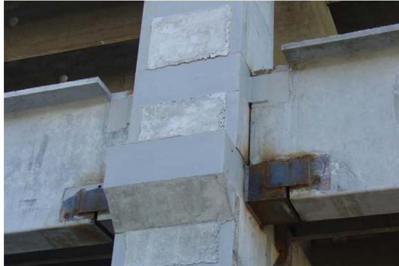
*Figura 1.23 Ejemplo de conexión seca.*
