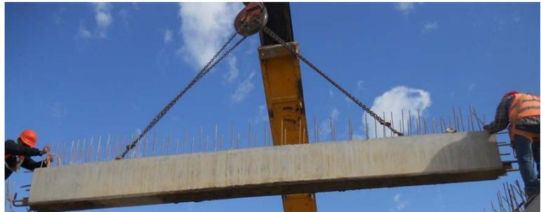
*Figura 1.31 Diferentes maneras de izar los elementos prefabricados.*
