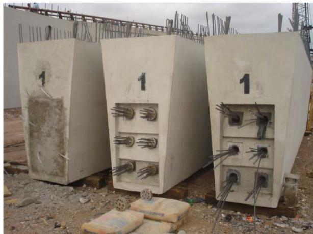
*Figura 1.9 Trabes para puente prefabricado y postensado.*
