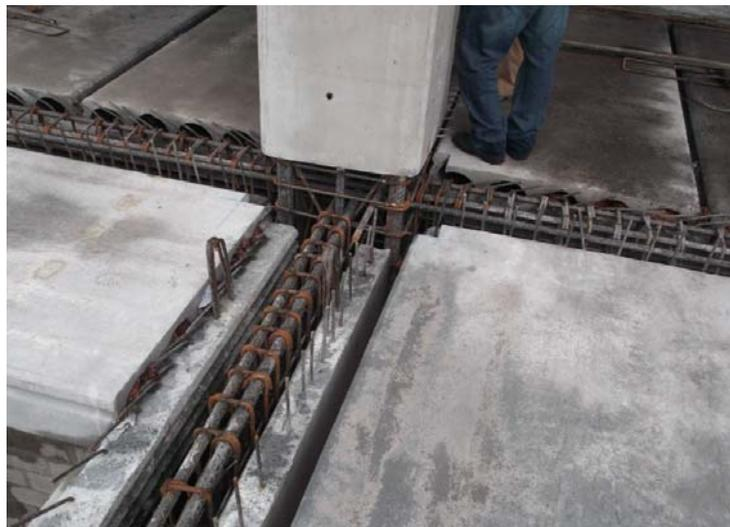
Figura 1.22 Ejemplo de conexión húmeda.
