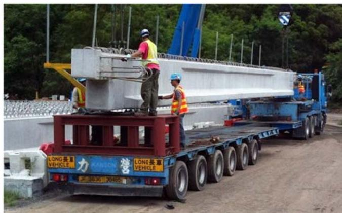
*Figura 4.5 Tractocamión y modular de 6 ejes.*
