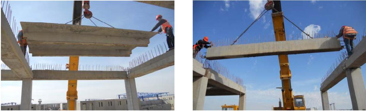
*Figura 1.34 Montaje de elementos prefabricados.*
