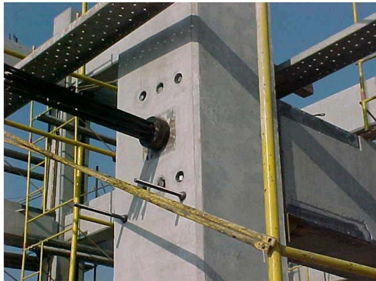
*Figura 1.24 Ejemplo de conexión híbrida.*
