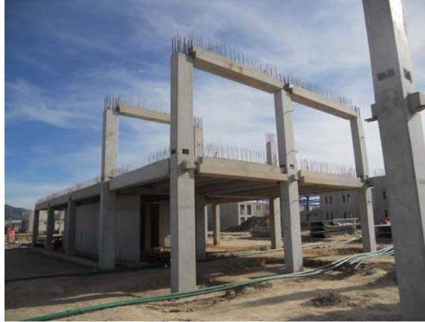
*Figura 1.7 Edificio prefabricado con acero de refuerzo simple.*
