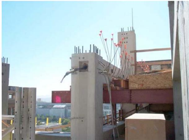
*Figura 1.8 Edificio prefabricado y postensado.*
