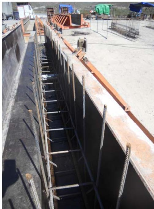
Figura 1.4 Prefabricados con acero de refuerzo simple.
