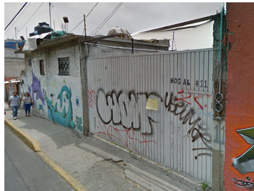
Fachada del predio
