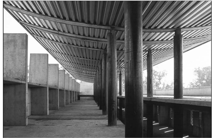
Imagen 57, 58, 59, 60. Proceso de construcción del FARO Oriente.
