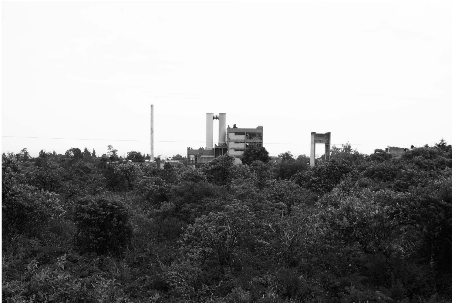
Imágen 12. Centro de Artes y Oficios "Tiempo Nuevo", Estado Actual
