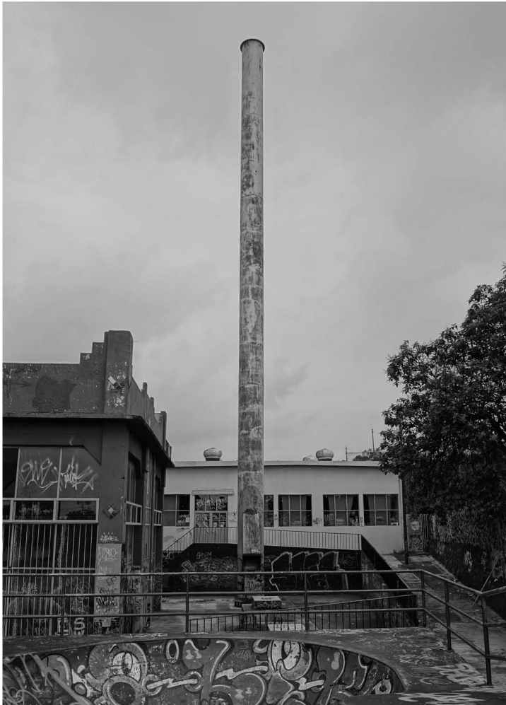
Imágen 14, 15. Centro de Artes y Oficios "Tiempo Nuevo", Estado Actual
