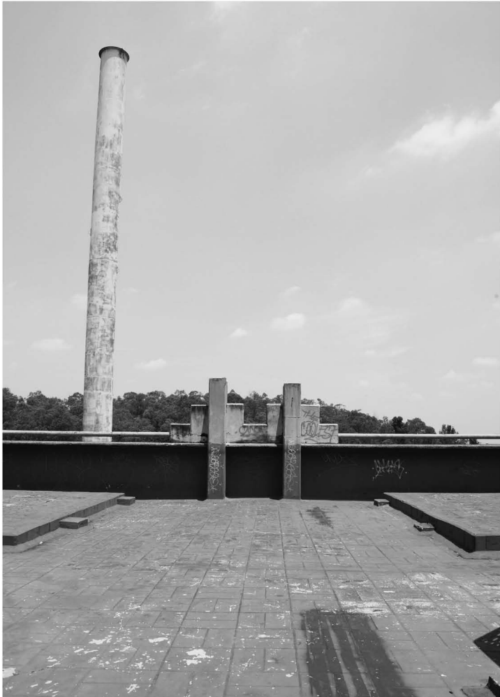
Imágen 18, 19. Centro de Artes y Oficios "Tiempo Nuevo", Estado Actual
