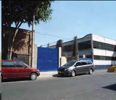
26 fachada calle fresno
