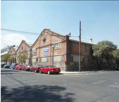
1 fachada de la calle clavel
