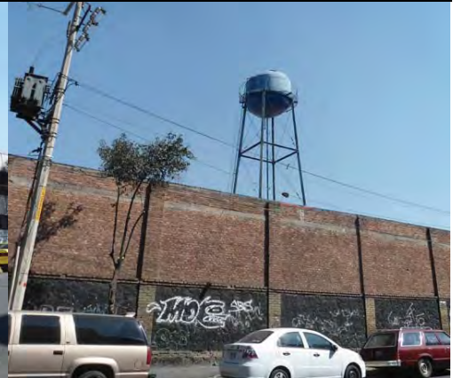
27 fachada calle fresno
