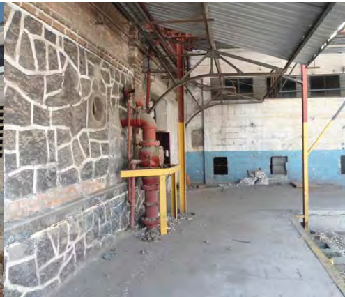
11 pasillo de circulación
