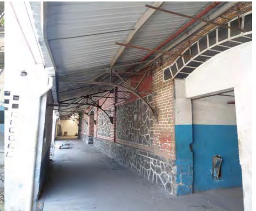
12 pasillo de circulación
