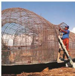
Estructura tridimensional a base de varilla y malla electrosoldada
