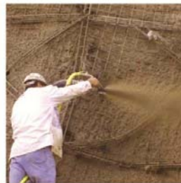
Aplicación de concreto lanzado sobre estructura tridimensional
