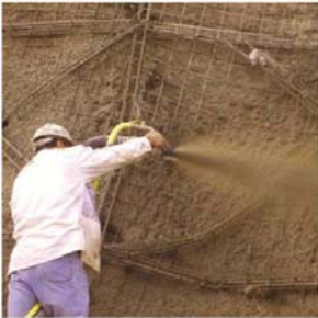
Aplicación de concreto lanzado sobre estructura tridimensional
